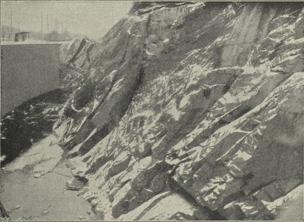
Fig. 5. Bergvägg i kraftkanalen. Gnejshällar, hvilkas stupning framträda å bilden och fått bilda kanalens vägg.
