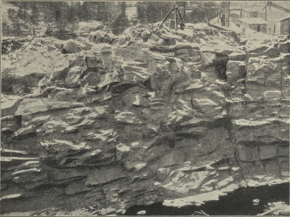
Fig. 6. Detaljparti i kraftkanalens gnejsvägg, nära kyrkan. Bergarten genomsatt af förskjutningssprickor, bäst synliga till höger å bilden.
