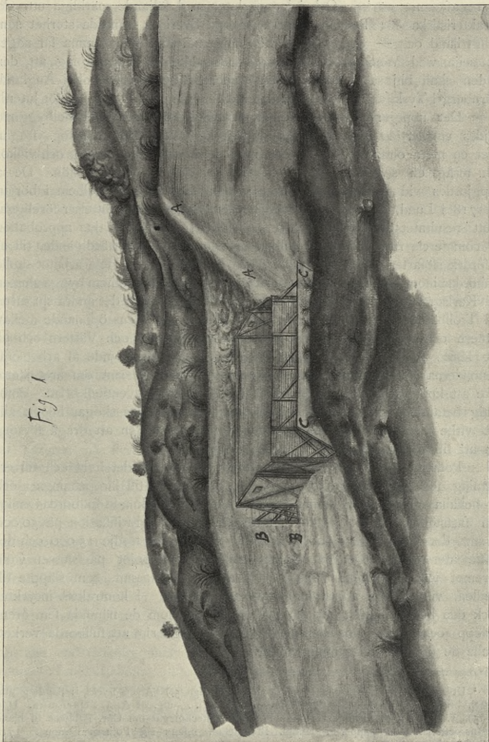
Fig. 12. Ritning på slussar af trä för att kringgå vattenfall af ända till 80 alnars höjd såsom vid Trollhättan. Ur: »Kungsboken». Riksarkivet. (Jfr s. 63).
