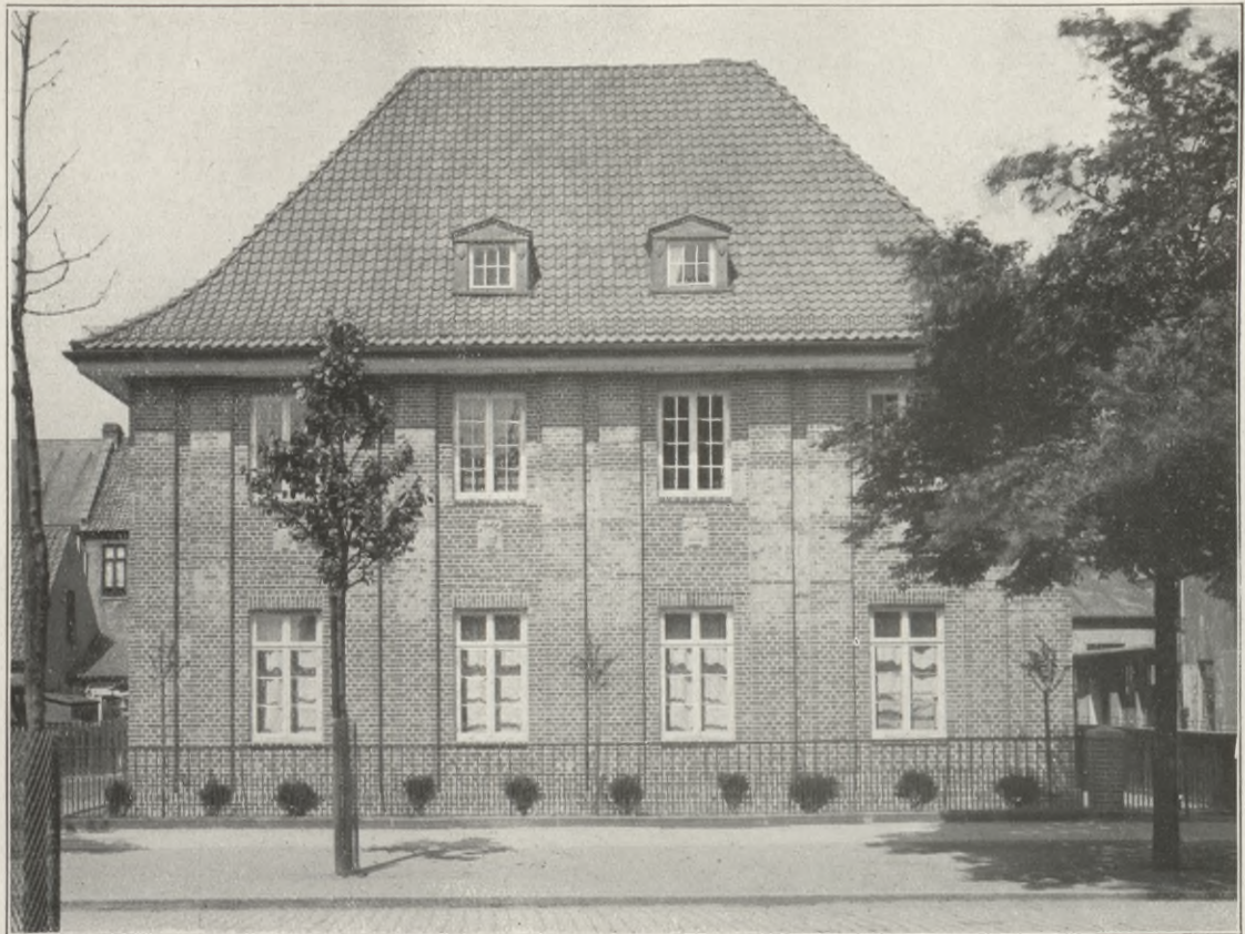
Abb. 6. Bremen, Pfarrhaus an der Hohentorchaussee. 1) Arch. Abbehusen & Blendermann, B. d. A., Bremen.
