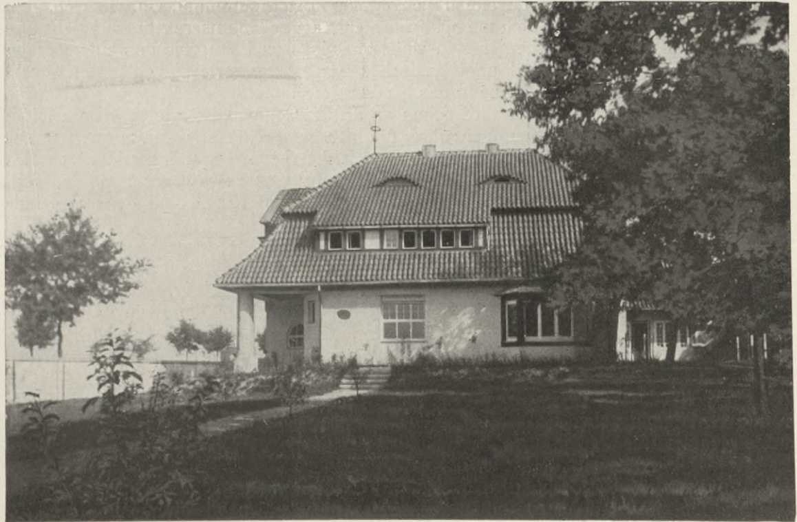
Abb. 114. Laage, Haus Korff. Südwest- und Südseite. 1) Arch. Paul Korff, Laage.
