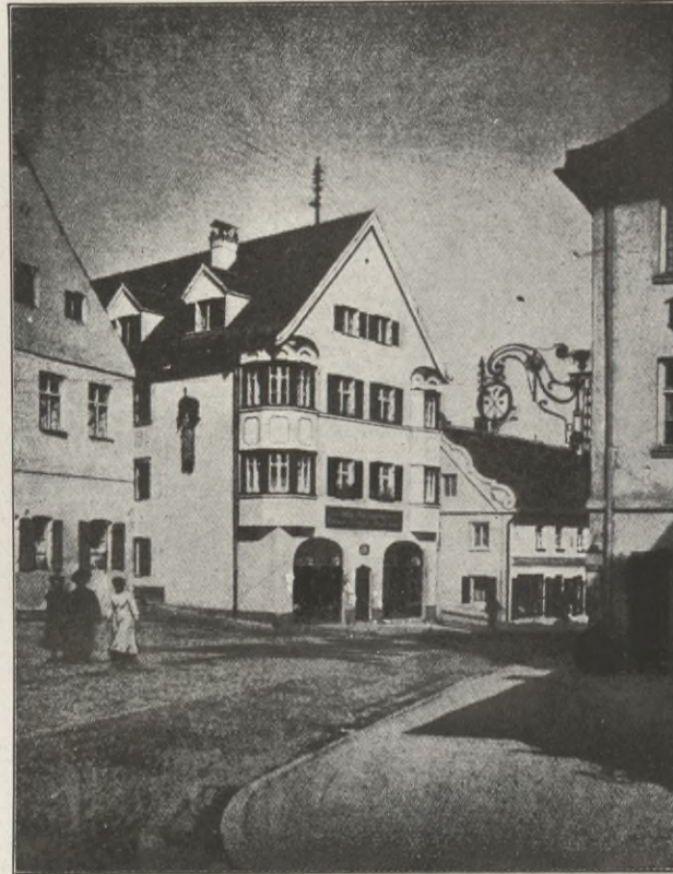
Abb. 82. Dachau, Wohn- und Geschäftshaus. 1)
