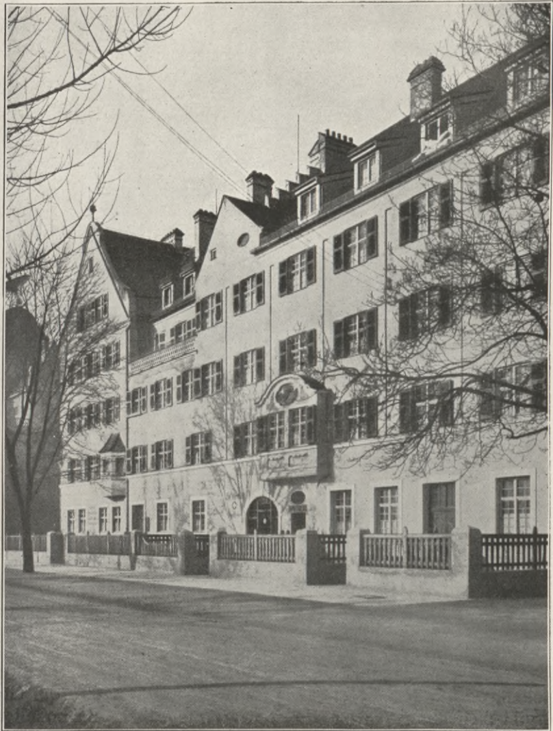
Abb. 20. München, Eckhaus an der Fürstenriederstraße mit einem weiteren Mietwohnhaus. 1)
