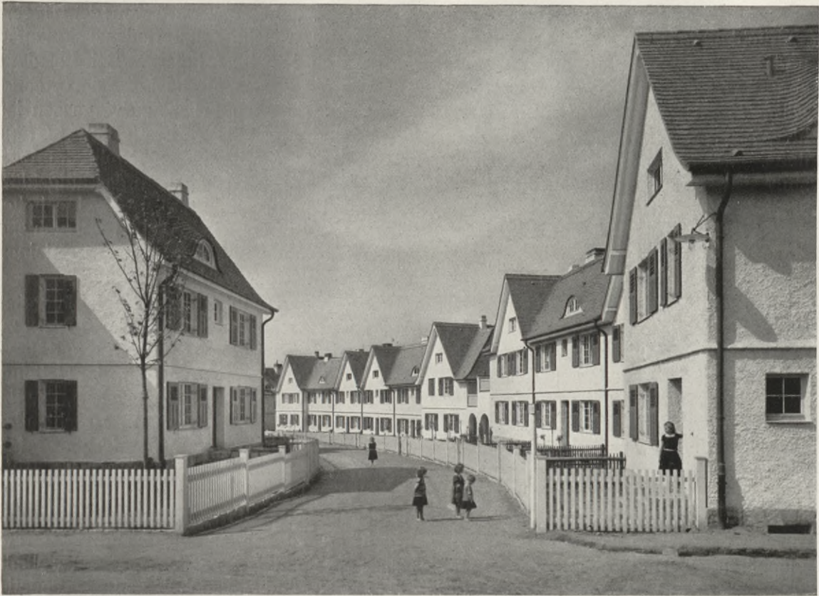
Abb. 13. Hellerau, Blick in die „Wohnstraße“ von der Hendrichstraße aus. 1)
