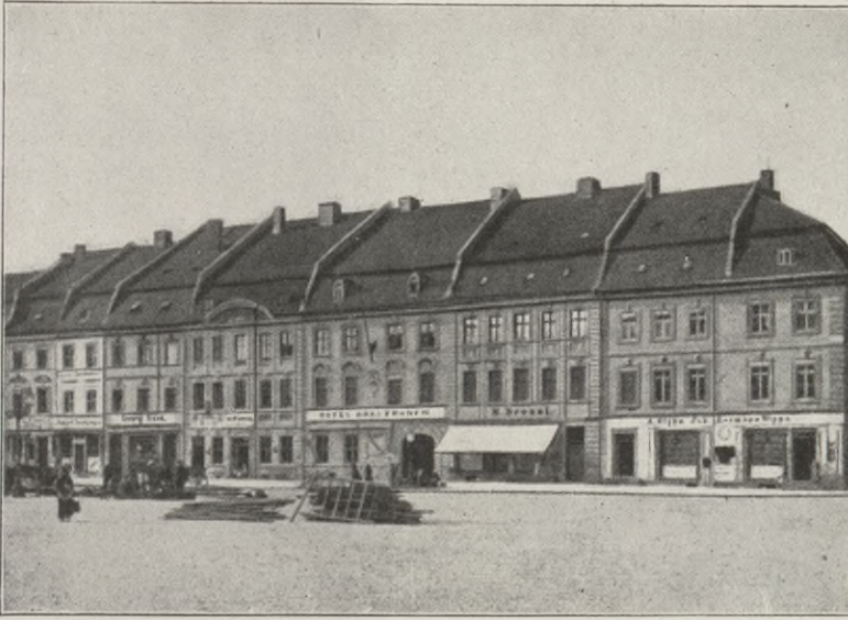
Abb. 101 Crossen, Westseite des Marktplatzes
