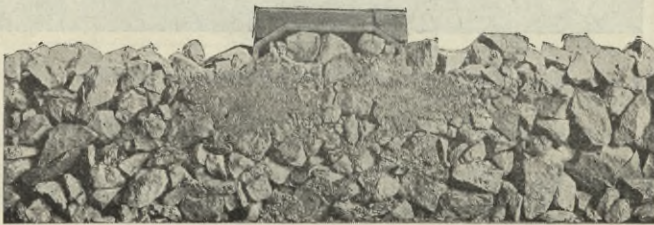
Schlackenbettung nach sechsmaligem Stopfen.
