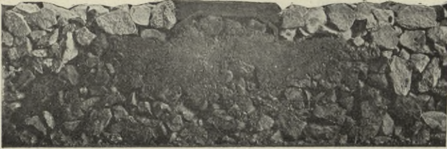
Schlackenbettung nach zehnmalem Stopfen.
