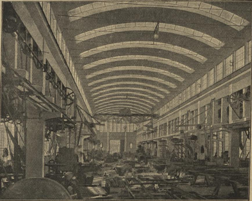
Dreifchiffiger Hallenbau in Eisenbeton. Werkstätte der Intern. Baumaschinenfabrik in Neutadt a. H.<sup>32)</sup>.
