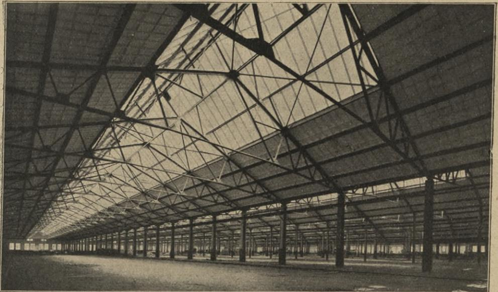
Mehrere gleich große Hallen von je einem Satteldach überdeckt. Eisenbahnhauptwerkstätte bei
