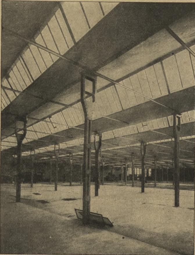
Sägefahed in leichter Eifenkonstruktion; Stützen zur Aufnahme von Lagern der Kraftleistungen <sup>19)</sup>.
