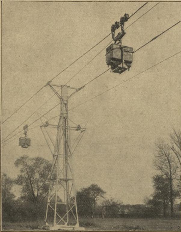
Drahtseilbahn (mit eisernen Tragstützen) zum Transport von kleinstückigem Malfengut. Nach Ausf. der Gef. für Förderanlagen *Ernst Heckel* m. b. H. in Saarbrücken.
