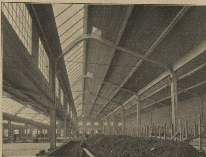
Sägehaddach in Eisenbeton mit Zugband<sup>20)</sup>.
