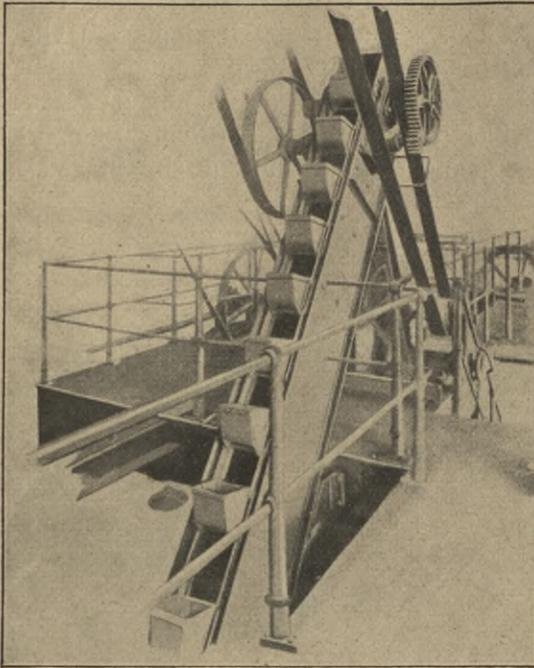
Becherwerk. Antrieb an der oberen Umführungstrommel.
