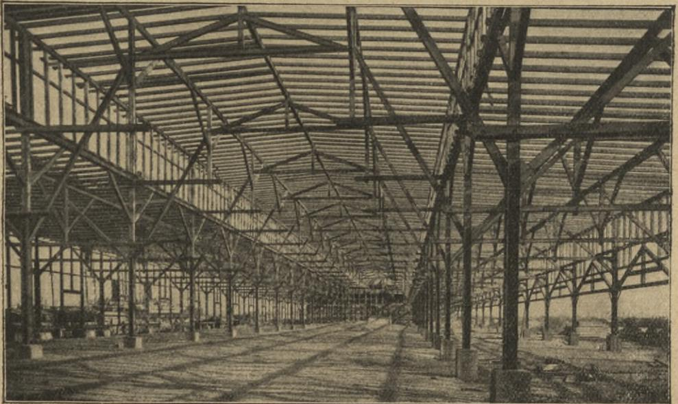
Dreischiffiger Hallenbau in Holzkonstruktion. Mittelschiff 20<sup>m</sup> breit, Seitenschiff 15<sup>m</sup>, Binderentfernung 9<sup>m</sup>; Lagerhalle im Hamburger Hafen. Erbaut von der Hafenbauverwaltung.
