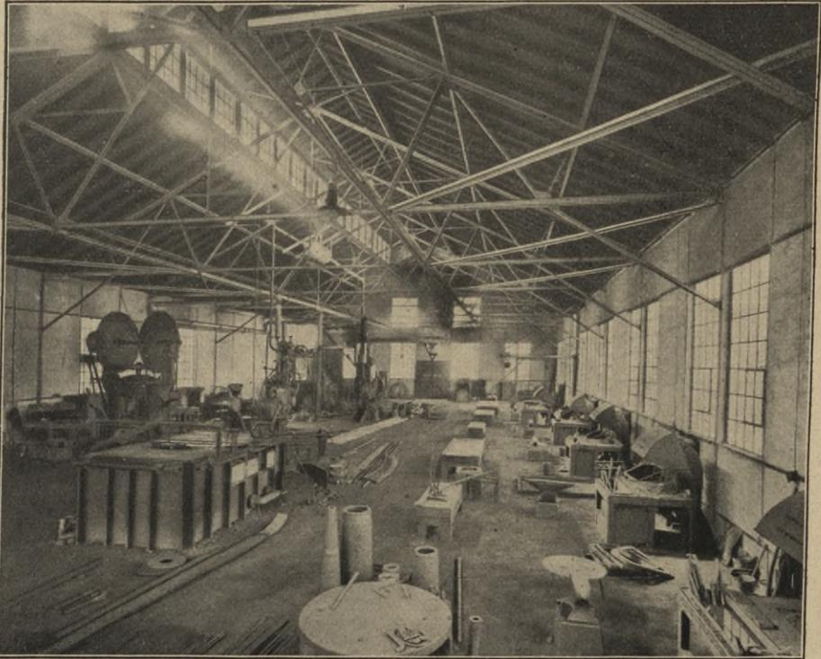
Einblick in eine Schmiede mit unterirdischer Rauchabführung. Großer Glühofen, Dampfhammer, Richtplatten usw. (Werner Geub).
