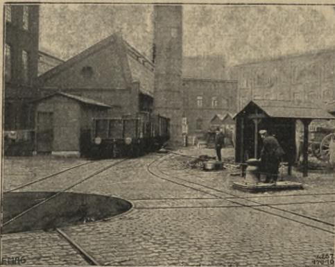
Normalspurige verfenkte Schiebebühne mit elektrischem Antrieb. Daneben ein Wagenkipper. Nach Ausf. der Deutschen Maschinenfabrik A.-G. (DEMAG) in Duisburg<sup>98)</sup>.
