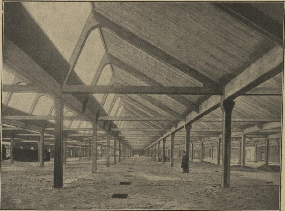
Sägeshed in Eisenbeton mit Zugbalken.
