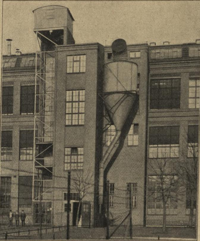
Flihkraftstaubfänger (Späneabscheider) an der Wand eines Gießereibaus. Außenliegender Lastenaufzug. Holzdrahtvorhänge (Sonnenfchützer) vor den Fenstern.
