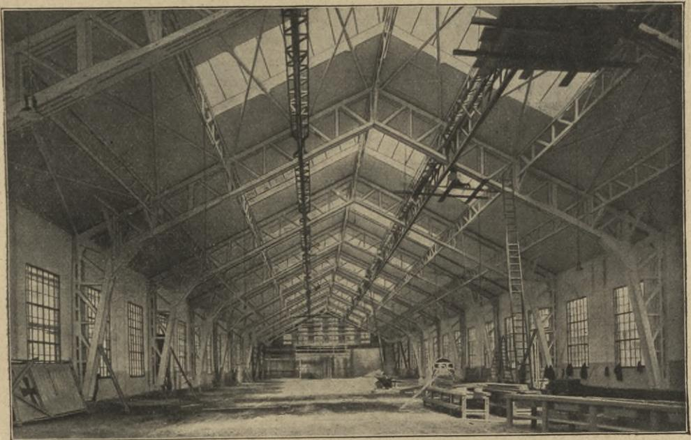
Werkstätte der *Siemens-Schuckert-Werke* Nürnberg; ausgeführt von der Firma Holzbau System *Meltzer* in Darmstadt. Spannweite 26 m.
