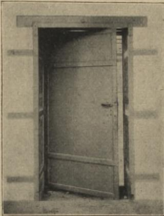
Einfl. eiserne Tür mit befäumtem Eisenblech in eiserner Zarge.
