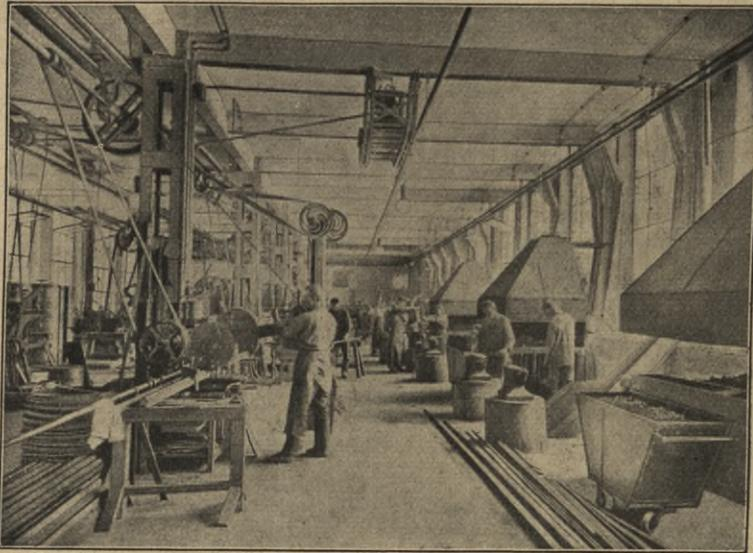
Einblick in eine Schmiede des Wernerwerkes der *Siemens- & Halske-A.-G.* (vergl. auch Fig. 7 und 27). Rauchabführung durch Rauchröhren in den Fensterfeilern.
