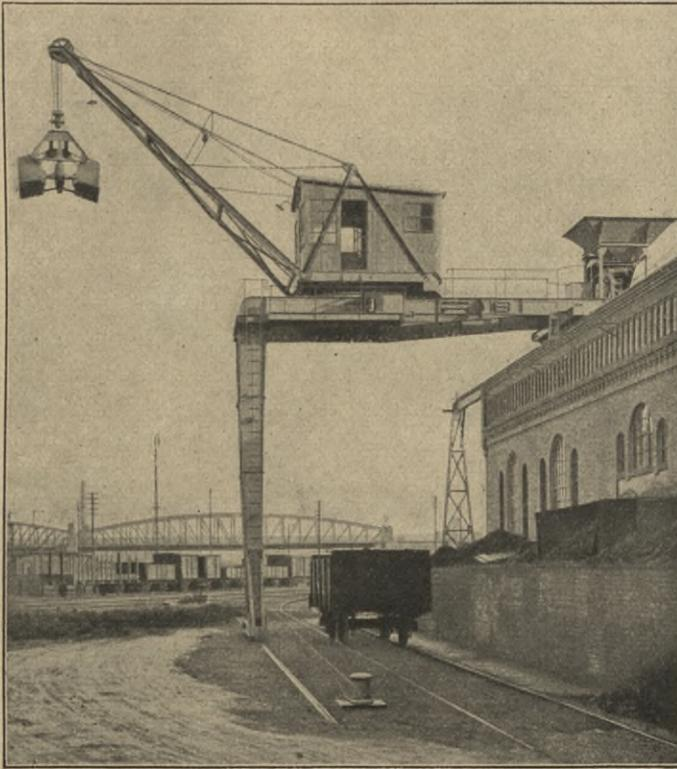
Halbportal-Drehkran mit Kohlengreifer und automatischer Wage.
