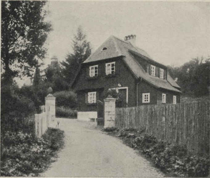
Verwalterhaus in der Rhön. Ansicht nach der Straße *).
