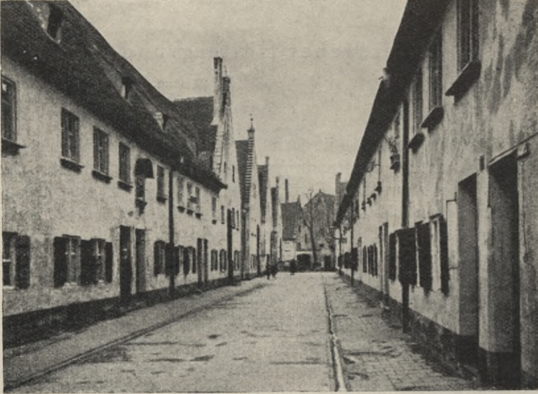
Straßenbild aus der Fuggerei in Augsburg *).
