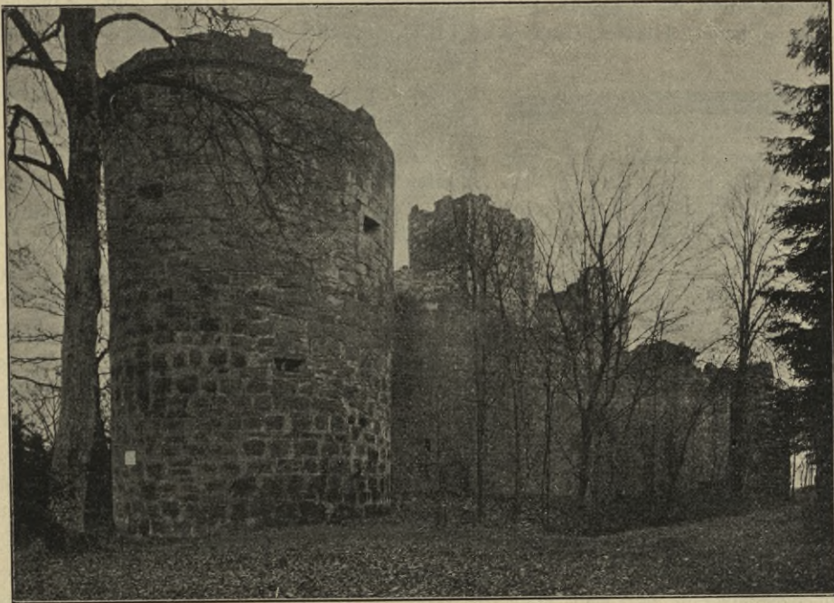
Fig. 7. Oestliche Burgmauer, Blick in den Halsgraben.
