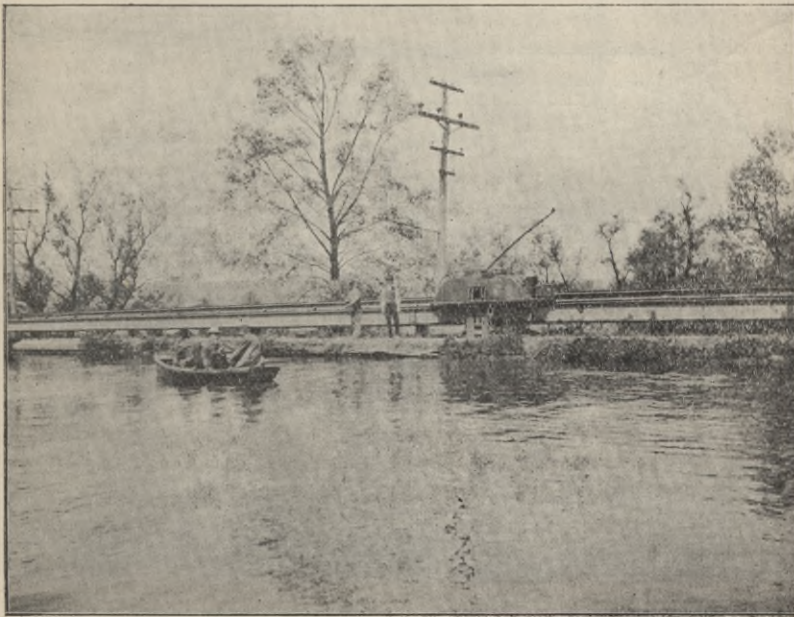
Fig. 4. — Erie Kanal, Schenectady N. Y. : Ansicht einer Lokomotive von 100 HP bei doppelgleisiger Anlage.
