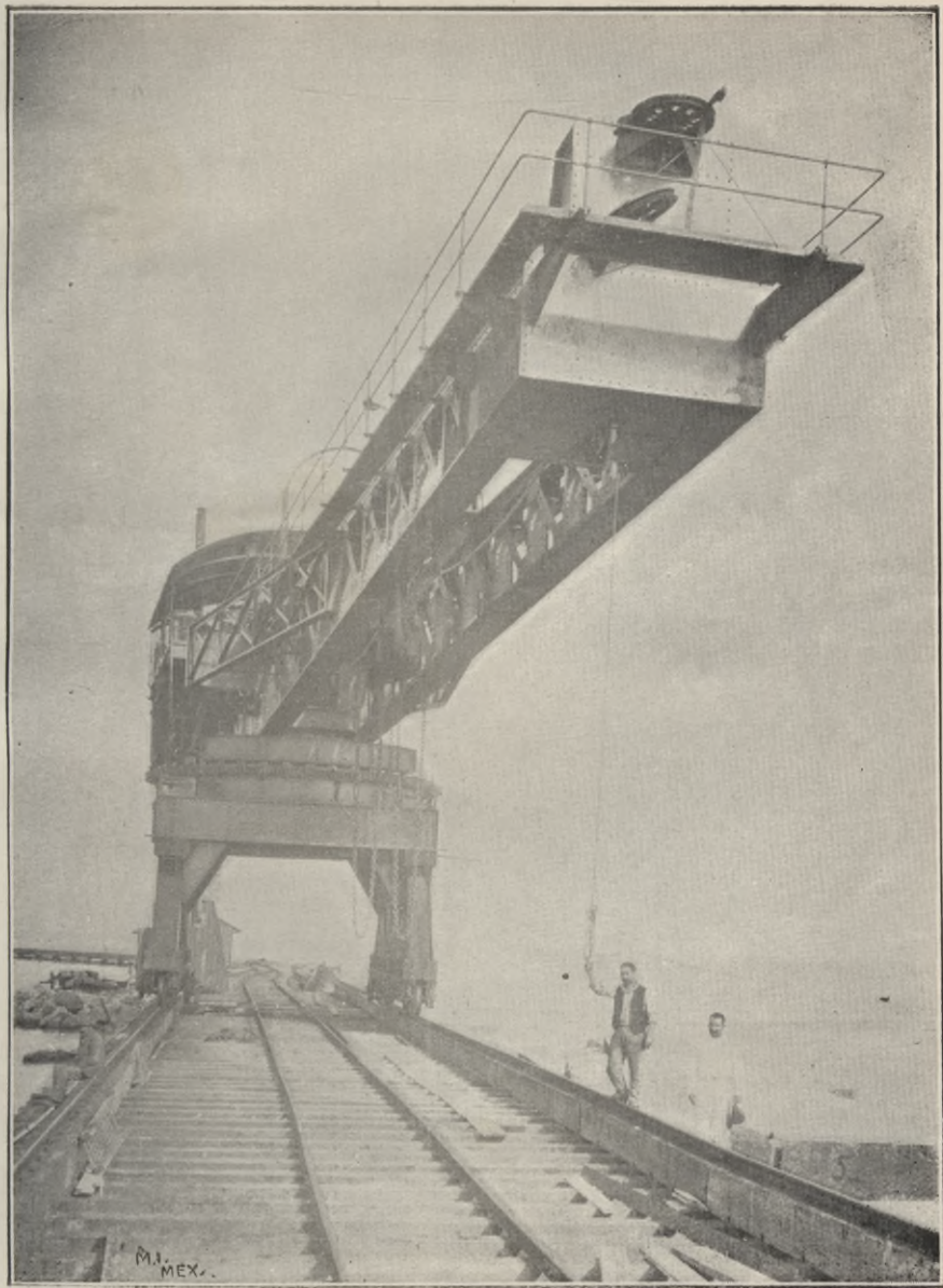
Grue "Titan" de 40 tonnes.
