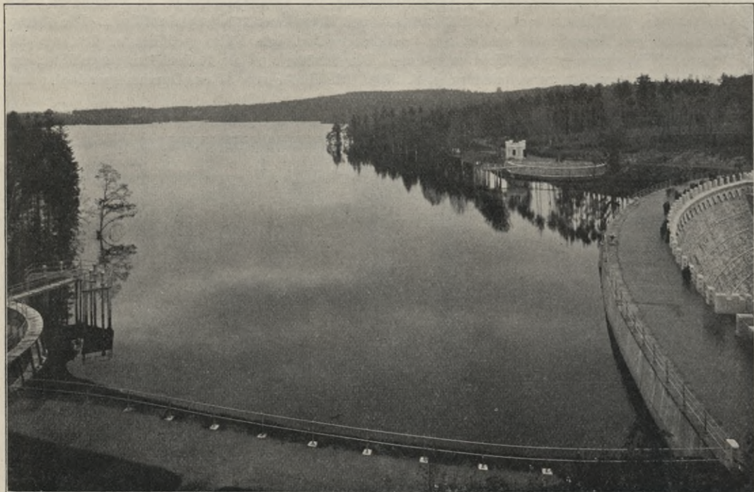
Abb. 256. Das Hochwasserschutzbecken im Queis bei Marklissa, gefüllt bis zu den Entlastungsanlagen in Höhe des Schutzraumes.
