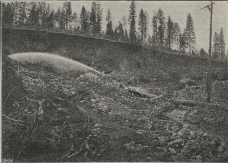
Abb. 184. Loslösung der Erde mittels Wasserstrahl und Förderung der Schütterde durch Spülung in Rohrleitungen bei Staudamm-Ausführungen in Amerika (Lake Frances-Damm in Kalifornien).
