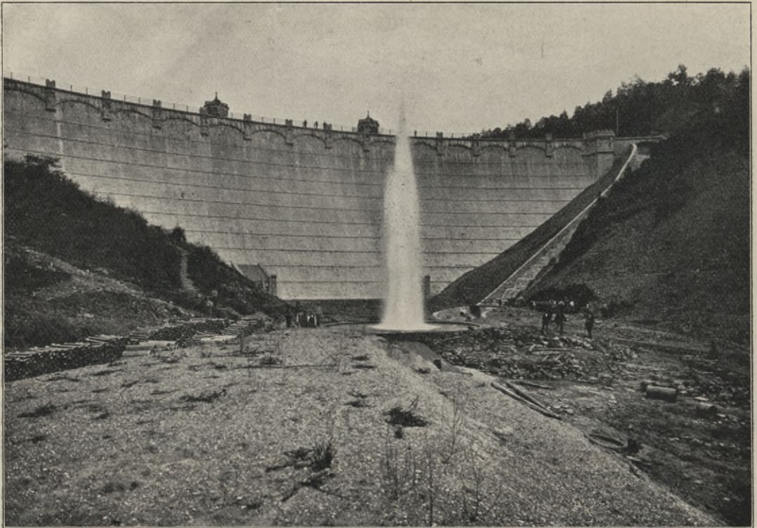
Abb. 273. Auffrischung des Wassers für Trinkzwecke durch Springbrunnen an der Solinger Talsperre.
