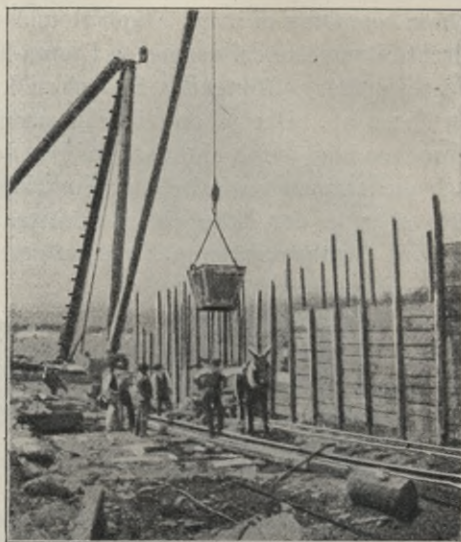
Abb. 175. Kranbetrieb bei Herstellung des Betonkerns für den Staudamm von Jersey City.
