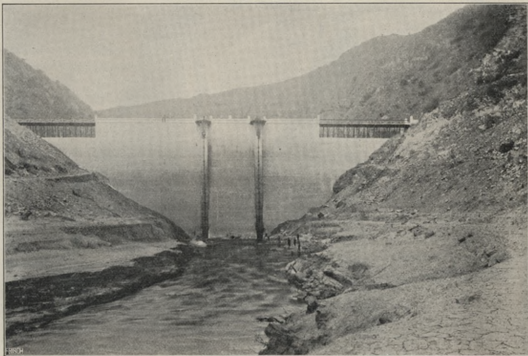
Abb. 238. Die Talsperre von San Roque in Argentinien mit ihren Betriebseinrichtungen: zwei seitliche Sandauslässe, in der Mitte die Nutzwasserentnahme. Zur Hochwasserentlastung zwei seitliche Überfälle von je 28,1 m Länge.
