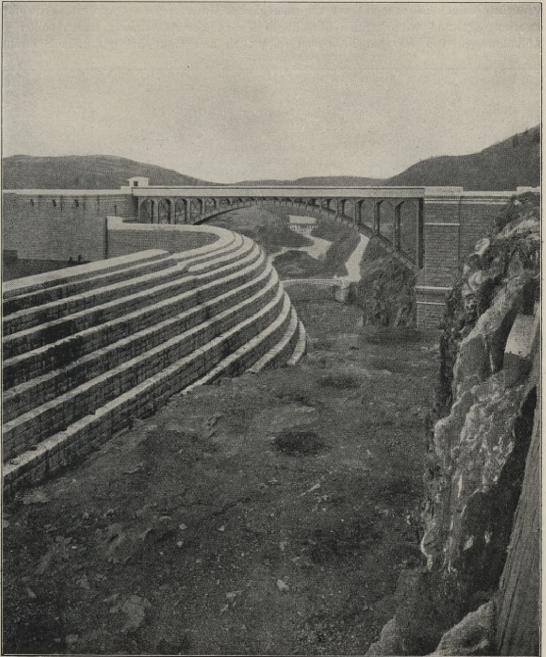
Abb. 231. Überlauf mit anschließender Kaskade an der Croton-Talsperre.
