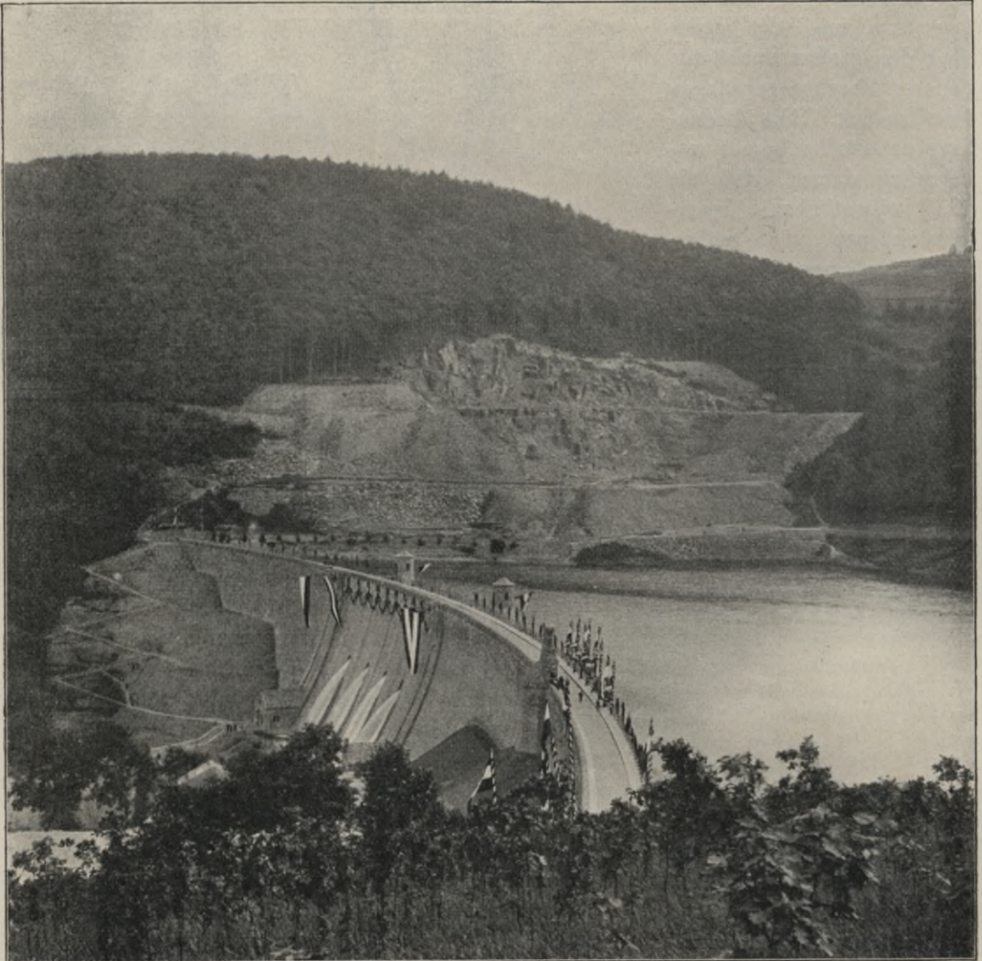
Abb. 246. Hochwasserentlastung der Mescheder Talsperre.
