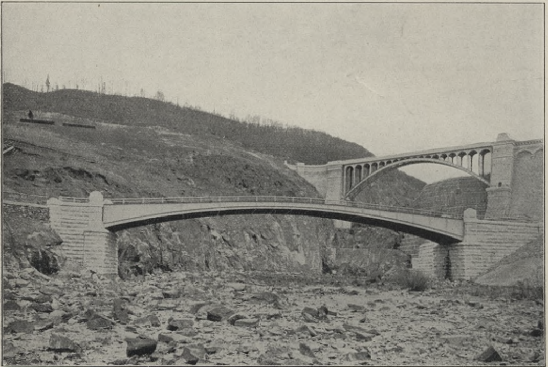
Abb. 232. Brücken über den Überfall und die Kaskade der Croton-Talsperre.
