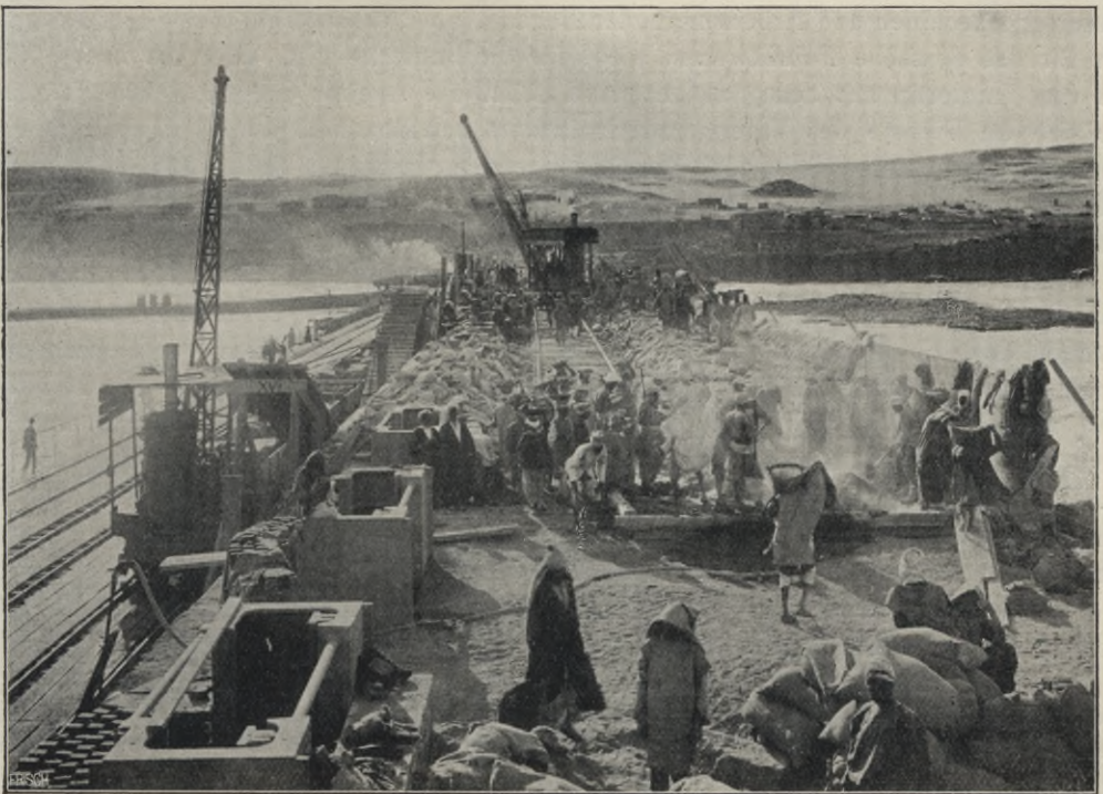
Abb. 303. Kranbetrieb und Mörtelbereitung beim Bau der Staumauer bei Assuan.
