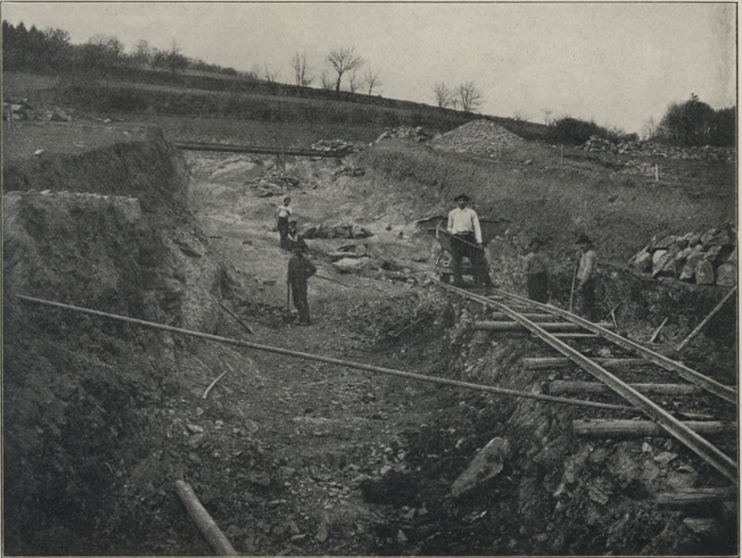
Abb. 293. Beginn der Felsarbeiten für die Freilegung der Baugrube der Mescheder Talsperre.
