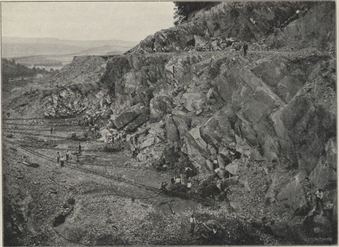
Abb. 289. Steinbruchbetrieb mit strahlenförmiger Anlage der Fördergleise beim Bau der Mescheder Talsperre.
