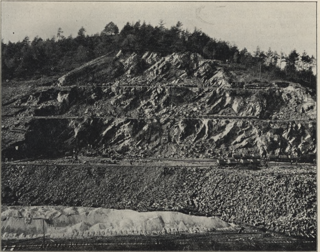
Abb. 287. Steinbruch in 3 Staffeln mit Gleisanschluß für Lokomotivbetrieb.
