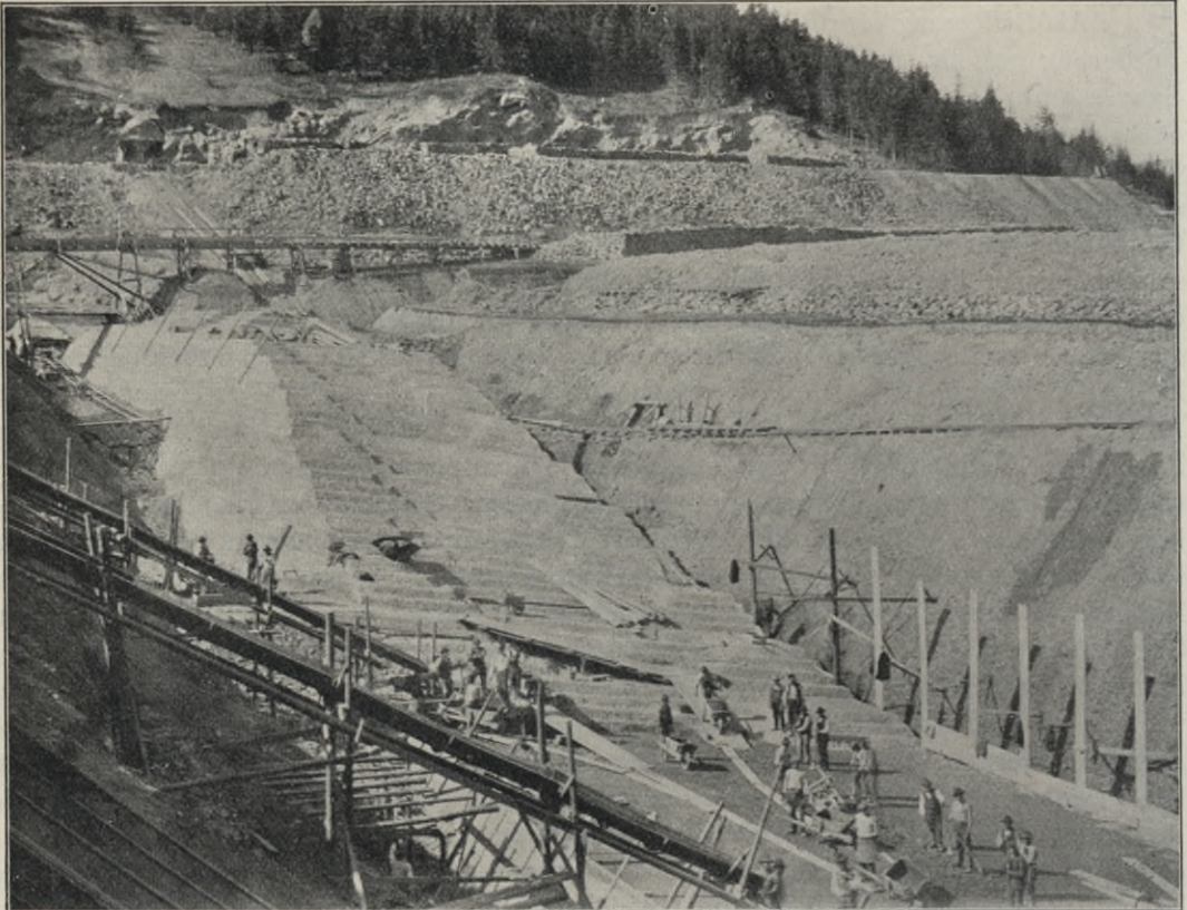
Abb. 314. Die Beton-Talsperre von Buchwald (Schlesien) im Bau.
