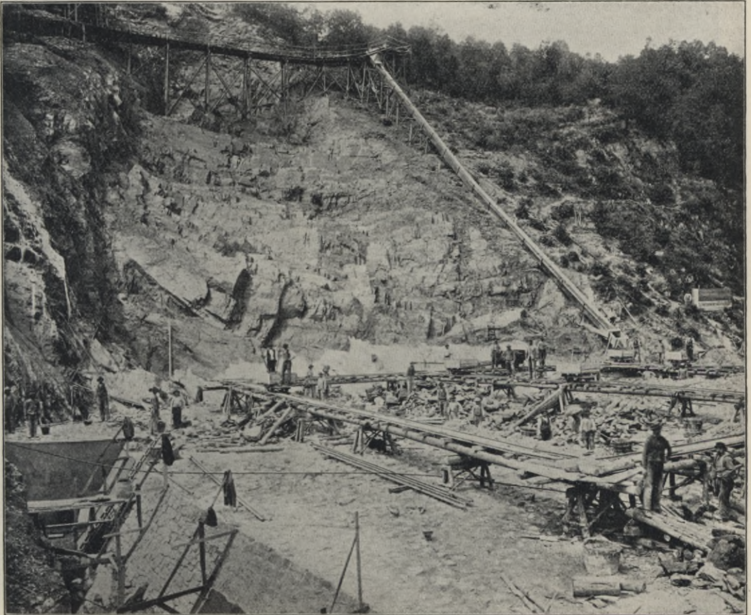
Abb. 298. Förderung der Baustoffe im Kreislauf.
