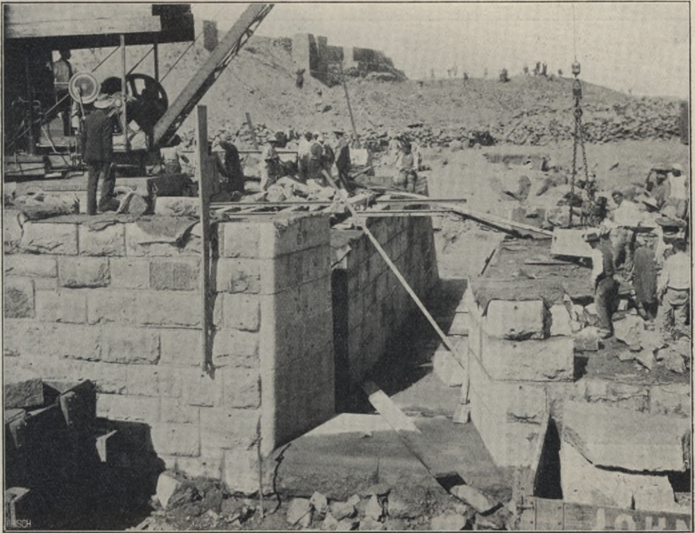
Abb. 304. Bau einer Schützenöffnung an der Staumauer von Assuan.
