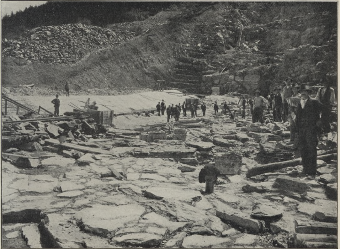
Abb. 296. Gründungsarbeiten beim Bau der Mescheder Talsperre.
