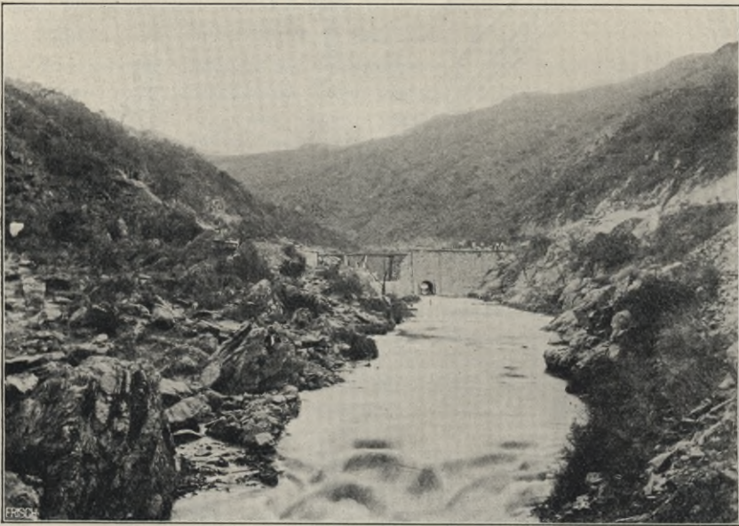
Abb. 285. Bau der Staumauer von Molet in 2 Teilen. Die Mauerhöhe über der Gründungssohle beträgt 14 m, die größte Mauerstärke 9 m.
