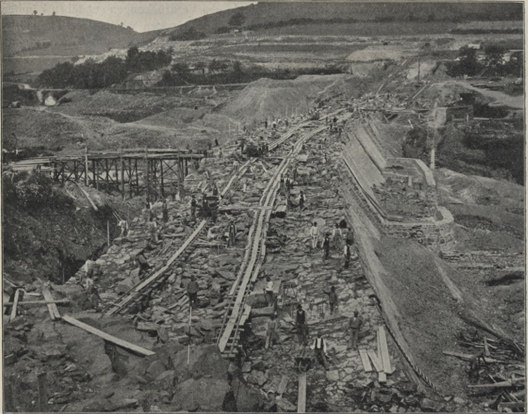
Abb. 308. Mauerarbeiten an der Mescheder Talsperre (1902/03). (Bruchsteinmauerwerk in Traßmörtel.)
