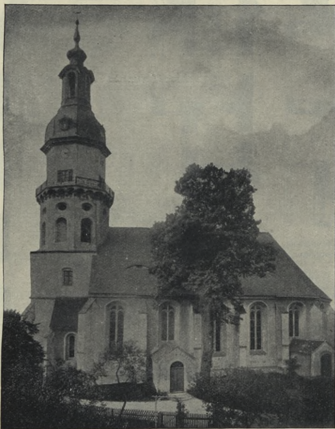
Fig. 76. Königsbrück, Hauptkirche, Südseite.
