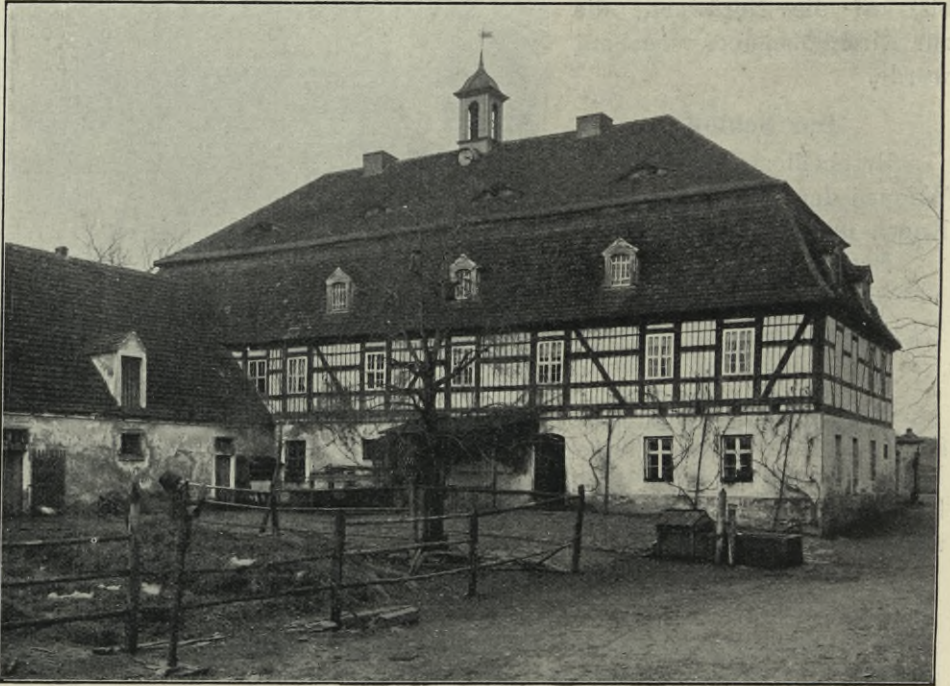
Fig. 319. Röhrsdorf, Rittergut, Pächterwohnhaus.
