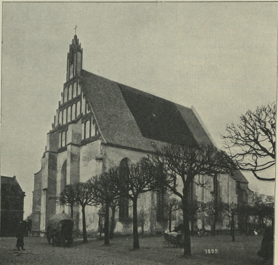
Fig. 175. Klosterkirche, Ansicht von Südwest.
