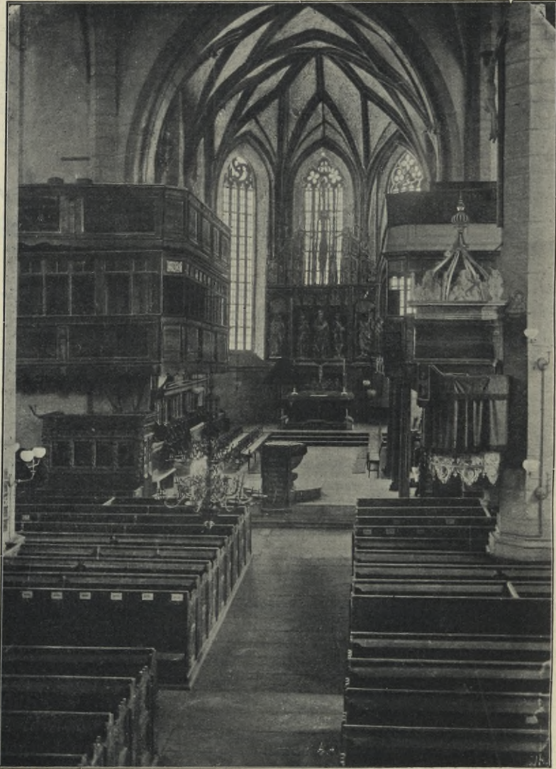
Fig. 3. Hauptkirche, Chor. Zustand vor 1908.
