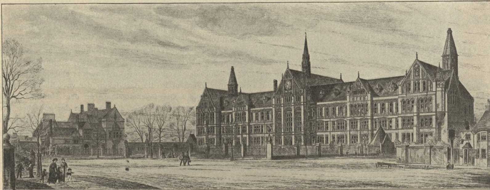
Abb. 160. Paulschule in Hammersmith, London. Gesamtansicht von der Strasse gesehen.
