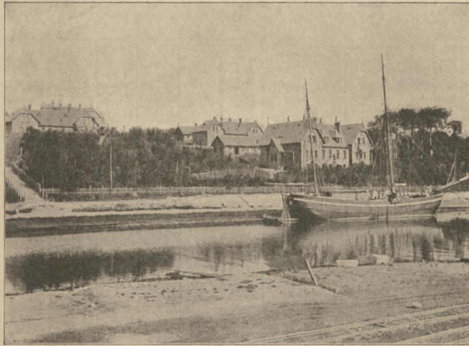
Abb. 336. Dienstwohngebäude bei Holtenau.
