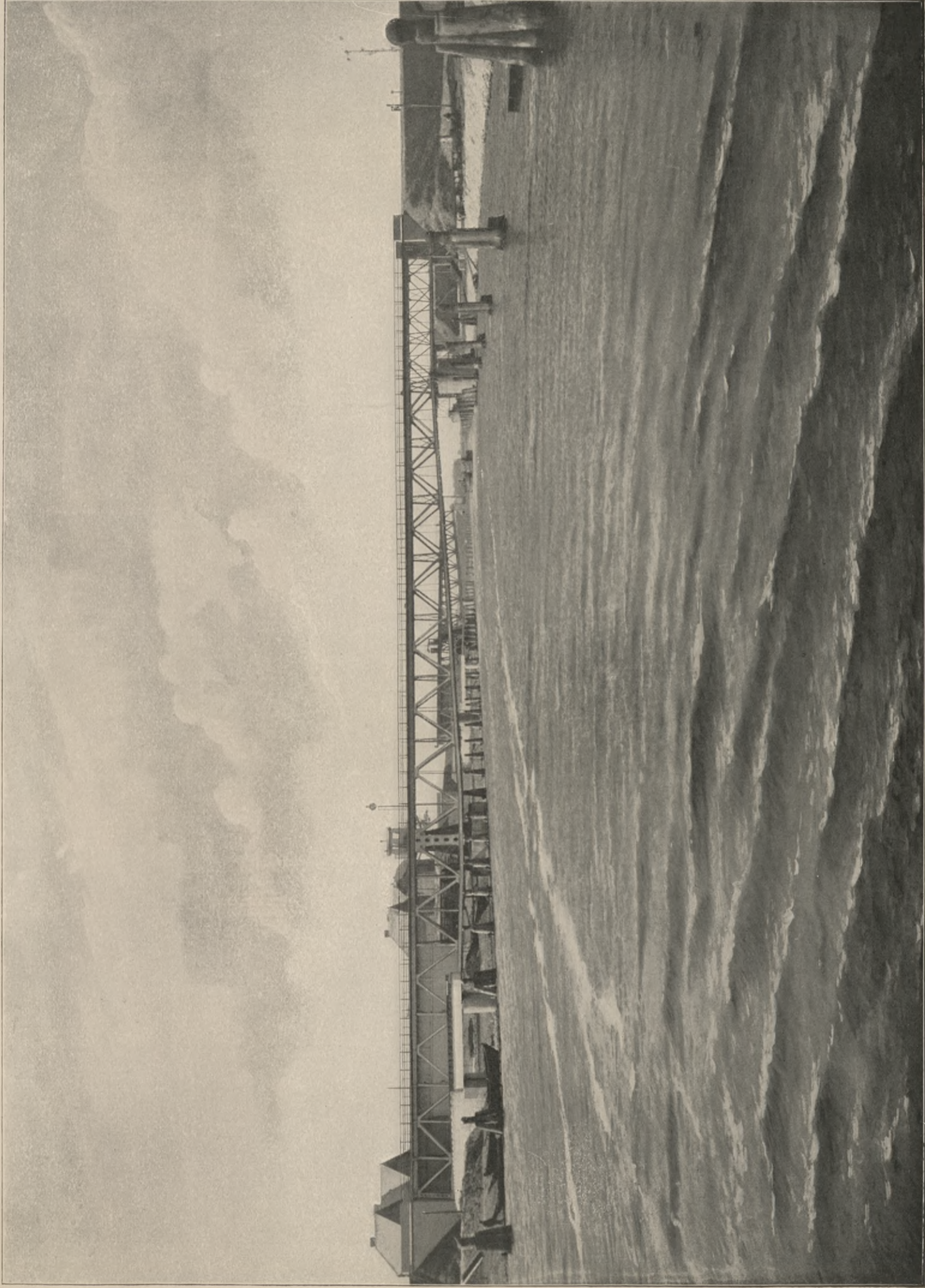
Abb. 320. Eisenbahndrehbrücken bei Osterrönnfeld. Von Osten gesehen. Mai 1895. Die östliche Brücke ist geschlossen, die westliche ausgedreht.
