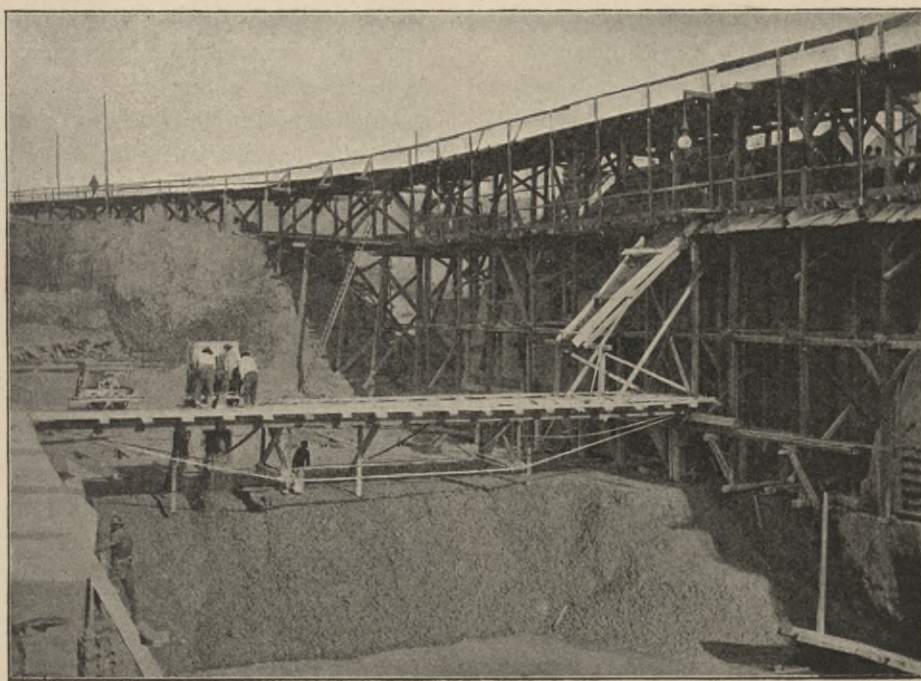
Abb. 118. Herstellung des Betonbettes der Schleusen-kammer-Sohlen.
