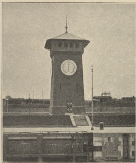
Abb. 119. Pegelthurm bei Holtenau.
