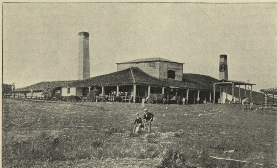
Abb. 12. Fabrikgebäude eines Ingenio.
