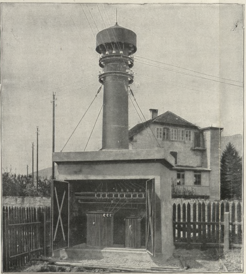
Figur 5. Transformatorhaus aus Beton mit Leitungsturm aus Blech der Kraftübertragung Hagneck.
