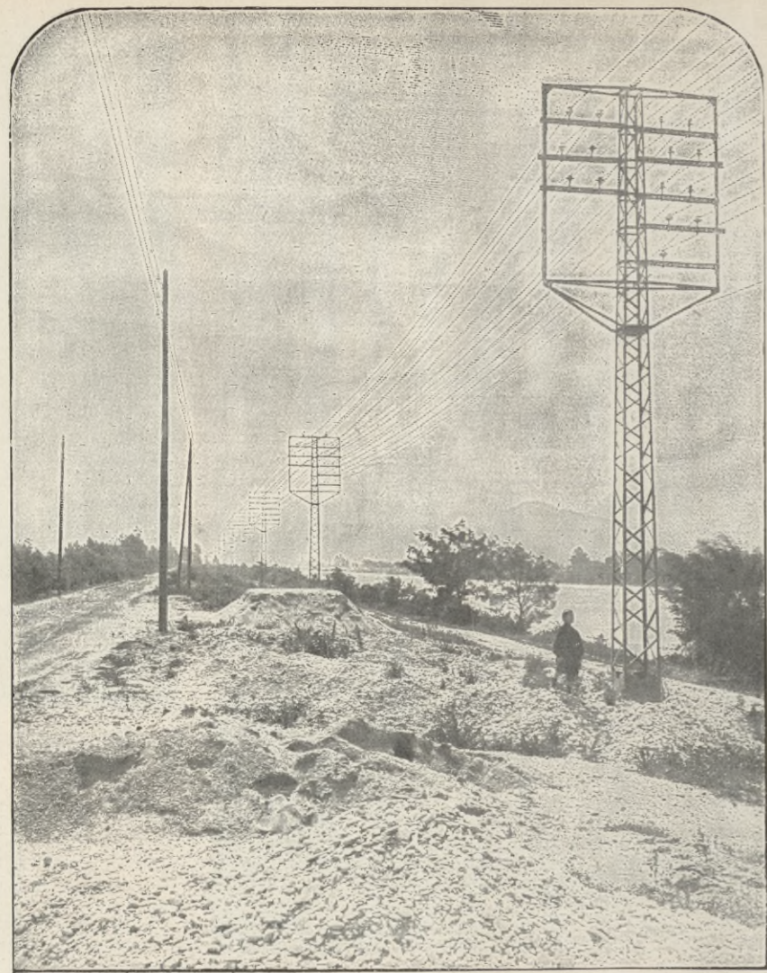
Figur 1. Fernleitung des Kraftwerkes Fure et Morge von Champ nach Moirans für 20 Drähte mit Rahmen für Schutznetze (vergl. S. 541).
