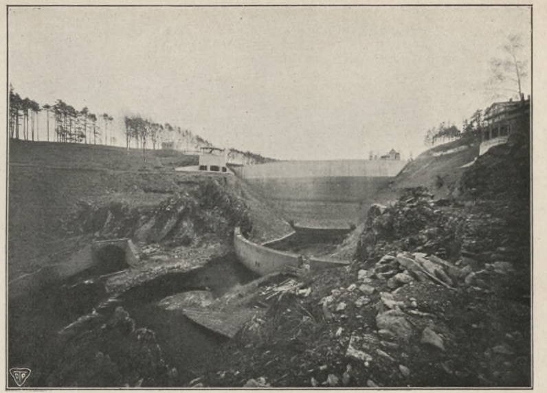
Figur 2. Blick auf das Hilfswehr und den linken Umlaufstollen.
