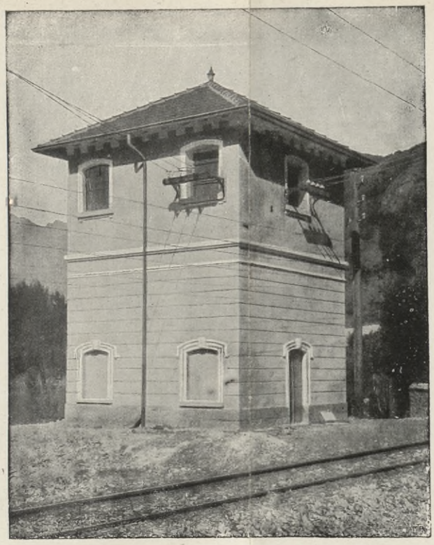
Figur 4. Transformatorhaus der Kraftübertragung Morbegno.
