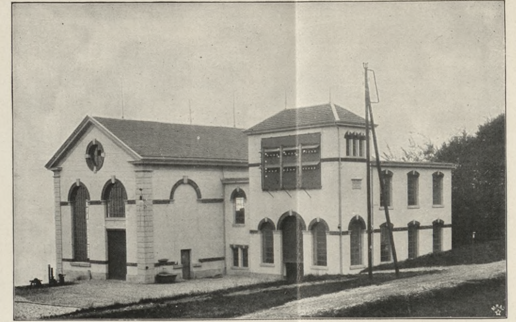
Figur 4. Ansicht des Krafthauses.
