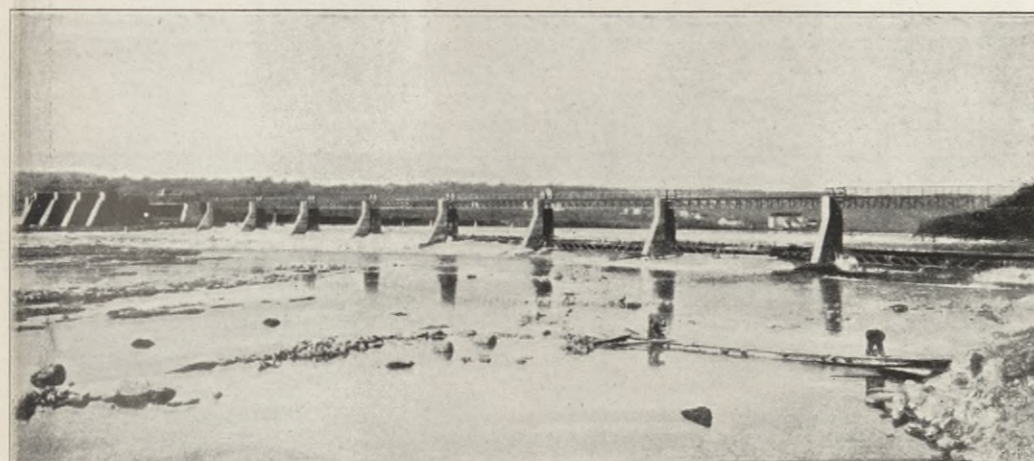
Figur 4. Ansicht des Wehres vom Unterwasser aus.
