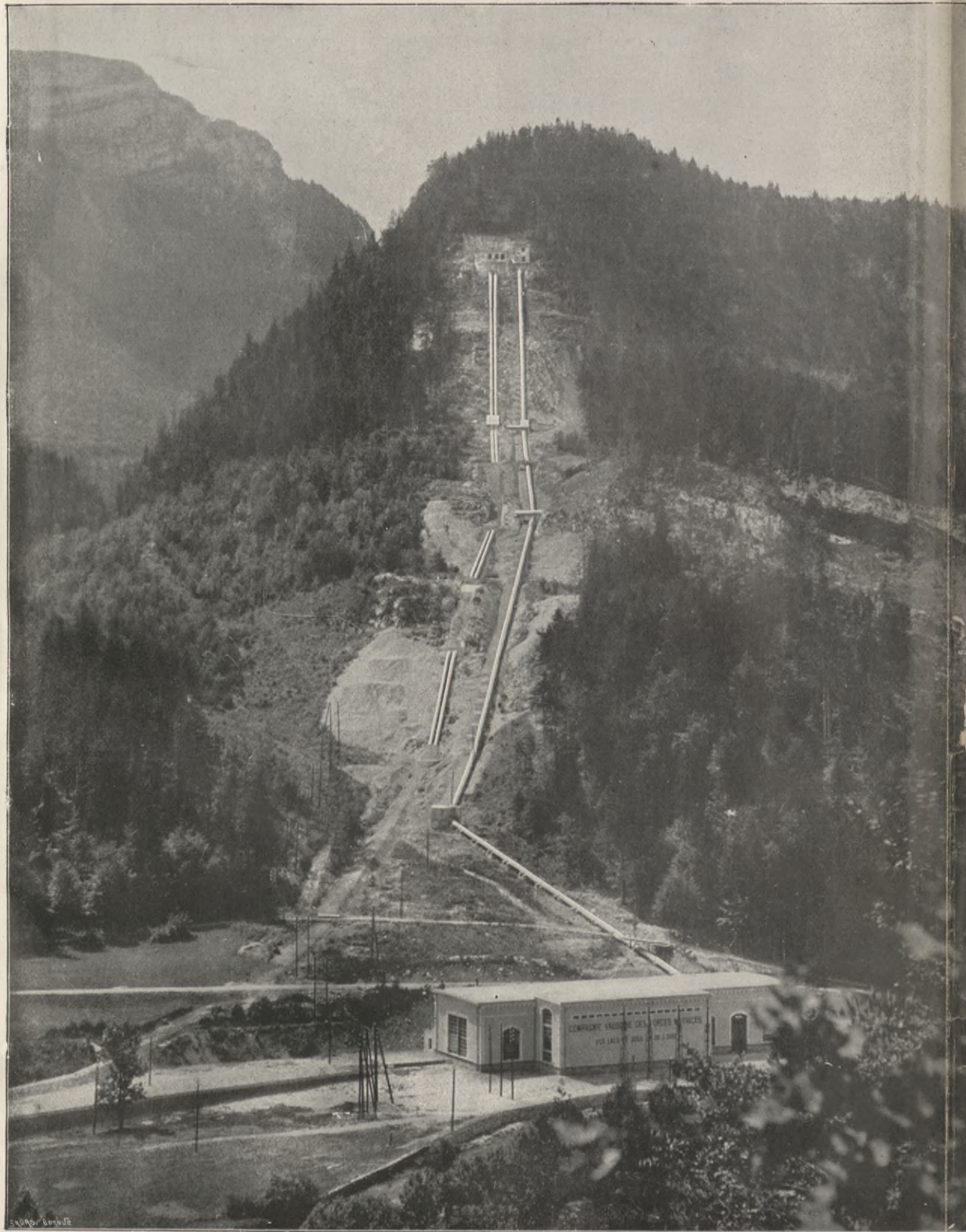
Figur 1. Ansicht des Krafthauses mit dem Druckrohr und den zwei Überlauf-Leitungen.
