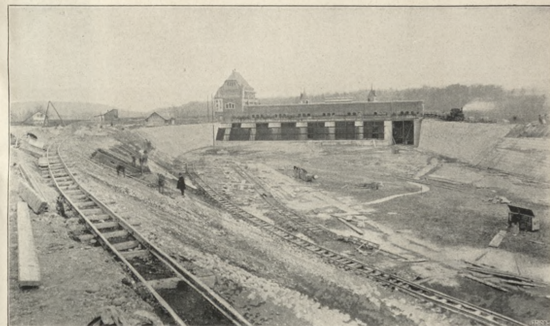
Figur 3. Ansicht des Krafthauses mit dem Vorbecken im Bau.
