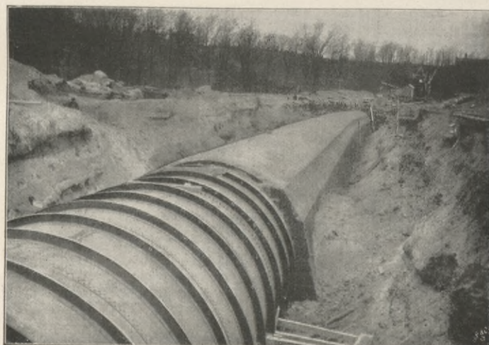
Fig. 6. Verlegung des Druckrohrs von 5,5 m lichtigem Durchmesser der Ontario Power Cy., vergl. Kap. II, 27 und Tafel XLIV.
