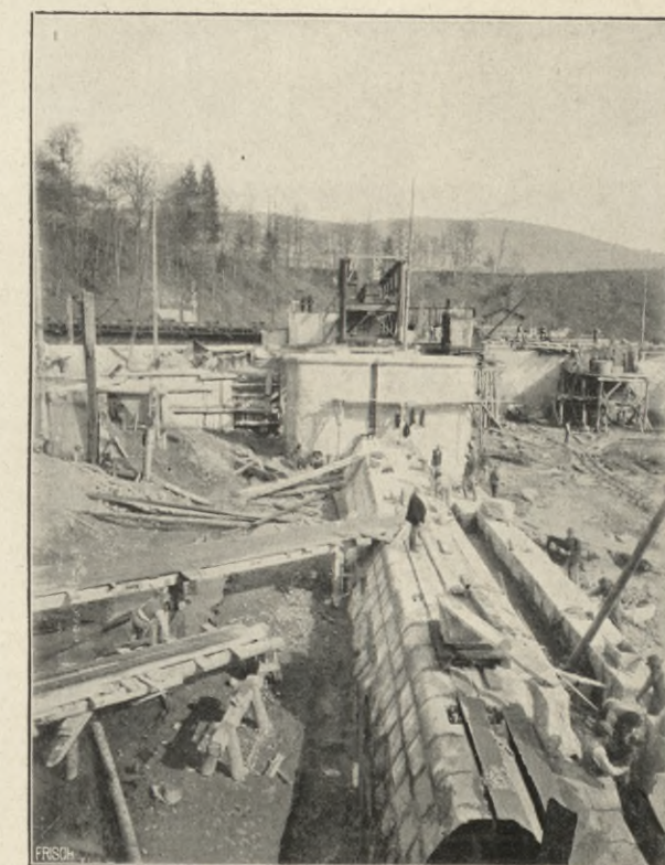
Figur 7. Ansicht des Stauwehres im Bau.
