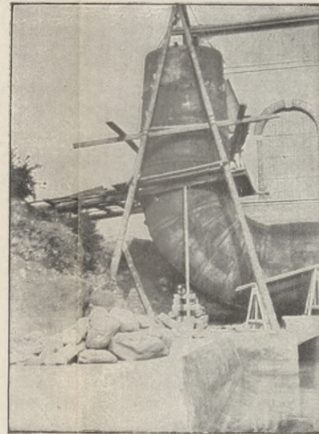
Fig. 2. Montage des Krümmers, vergl. Fig. 1.
