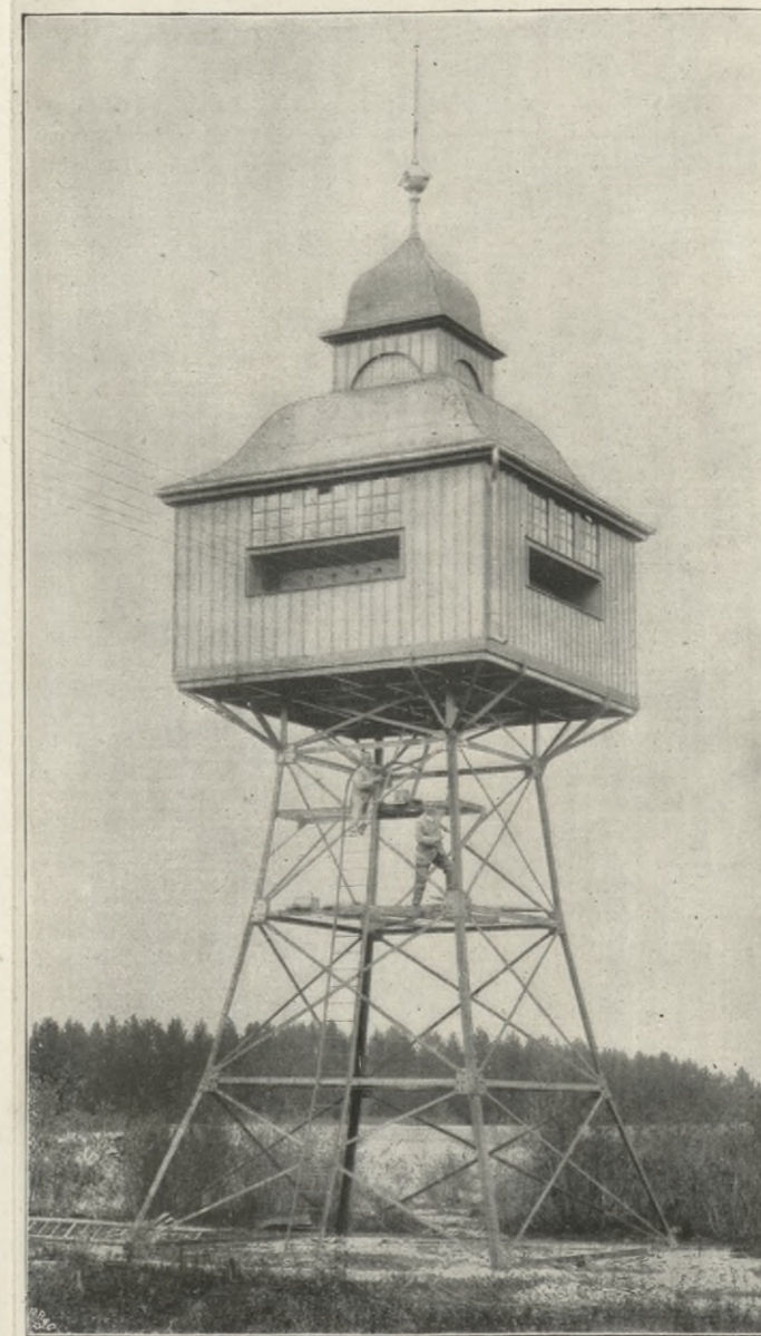
Figur 7. Verteilungsturm in der Nähe des Krafthauses des Werkes Gersthofen am Lech.
