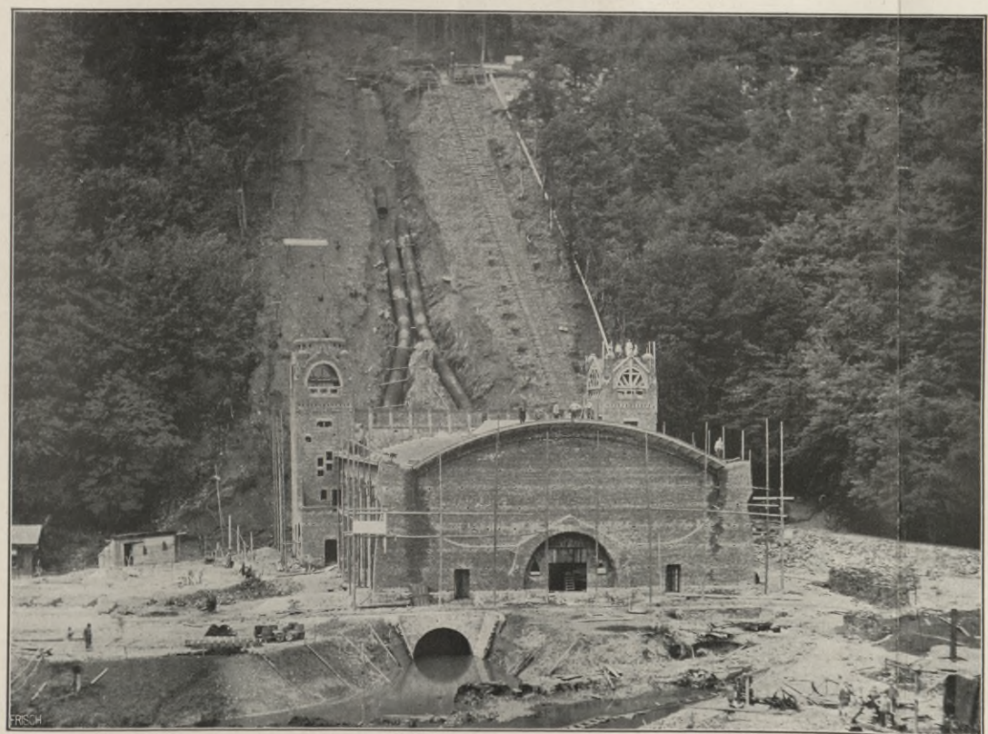
Figur 10. Ansicht des Krafthauses und der Druckrohrleitungen im Bau, Oktober 1904.
