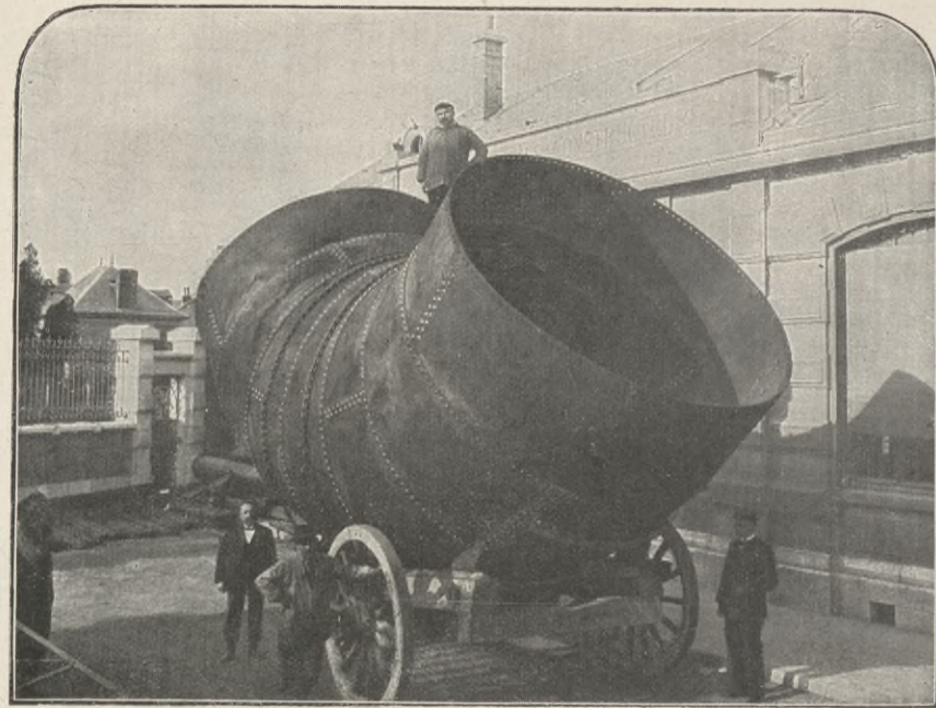
Fig. 1. Krümmer zum Steigerrohr der Anlage „Fure et Morge“, vergl. Kap. II, 26 und Tafel XLIII.
