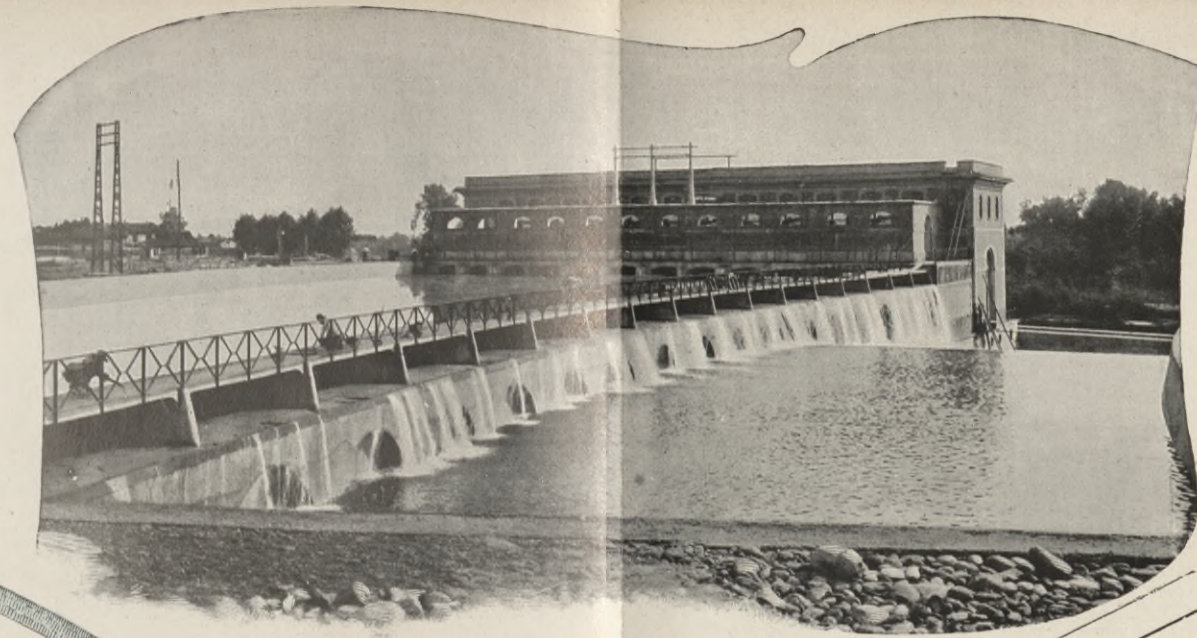
Figur 3. Ansicht des Überlaufs vor der Zentrale.
