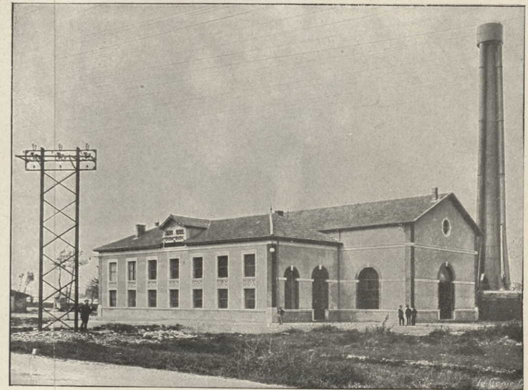
Figur 3. Ansicht des Krafthauses mit Steigerohr der Druckrohrleitung.
