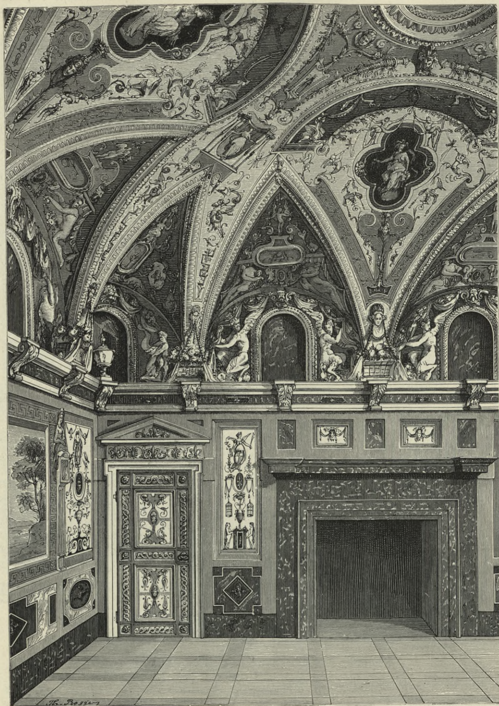
Fig. 205. Badezimmer im Fuggerhause zu Augsburg.
