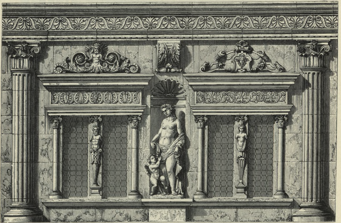
Fig. 213. Teil vom oberen Stockwerk des Otto-Heinrichsbaues.
