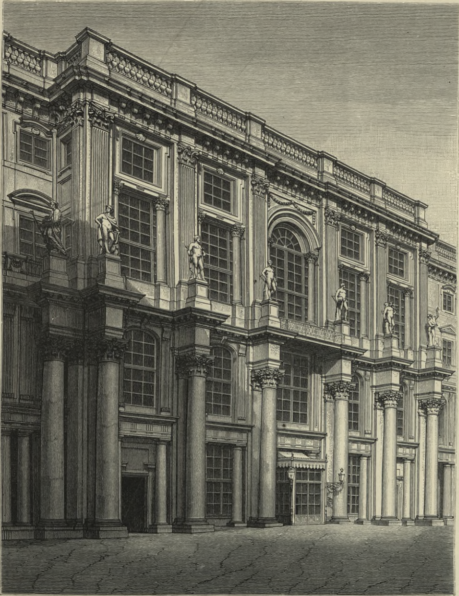
Fig. 403. Teil der Fassade des zweiten Hofes im Berliner Schlosse. Von Schlüter.
