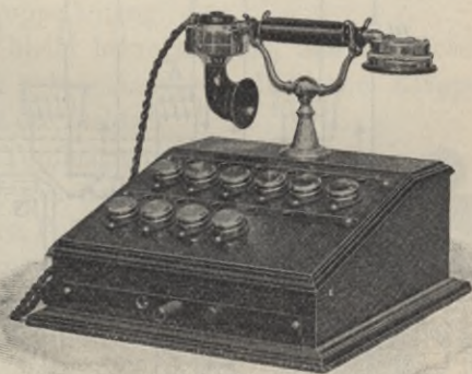
Abb. 316. Schnurloser Linienwähler, Tischstation, für Doppelleitung mit Geheimsprecheinrichtung und Anrufzeichen der Deutschen Telephonwerke, Berlin.
