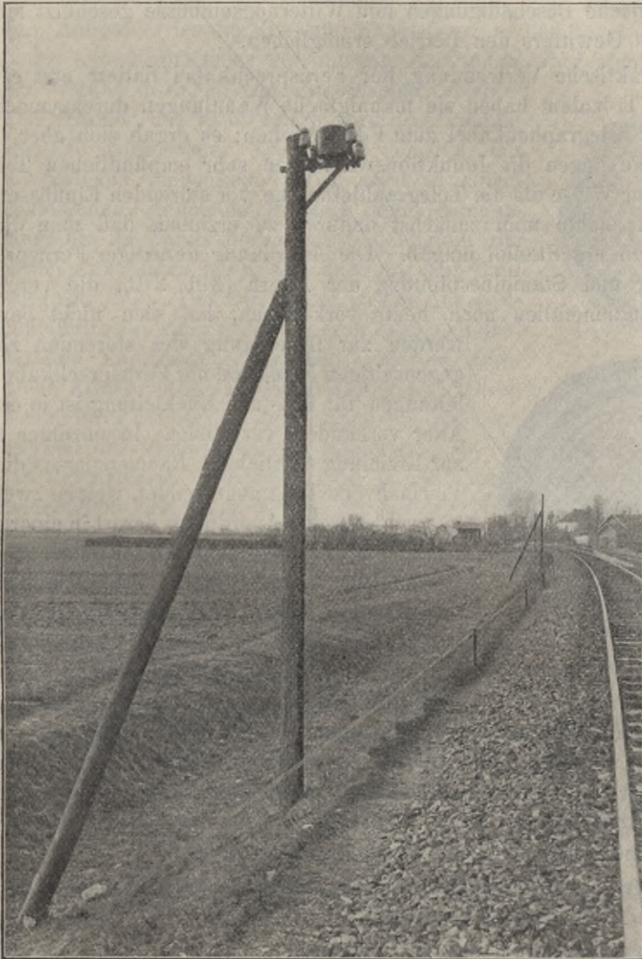
Abb. 269. Pupinspule für Freileitungen von Siemens & Halske, Berlin. Neueste Anordnung.
