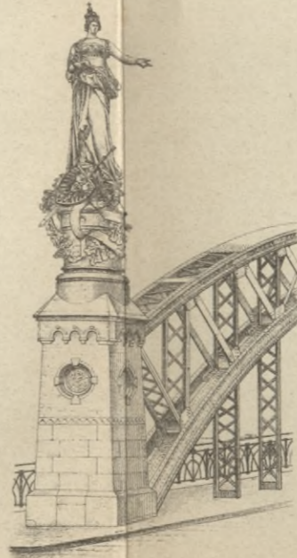
Abb. 22. Brooksbrücke in Hamburg.
