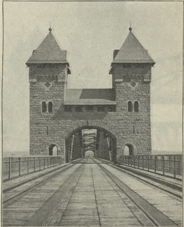
Abb. 17. Kaiserbrücke bei Mainz. Portal auf der Petersaue. 35)
