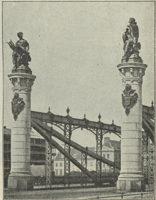
Abb. 10. Augarten-Brücke in Wien. 28)
