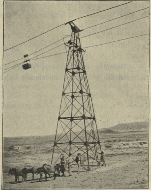
Abb. 77. Eiserne Stütze.
