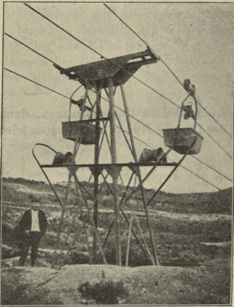
Abb. 76. Eiserne Stütze.
