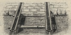
Abb. 50. Doppelschienengleise für Feldbahnen.
