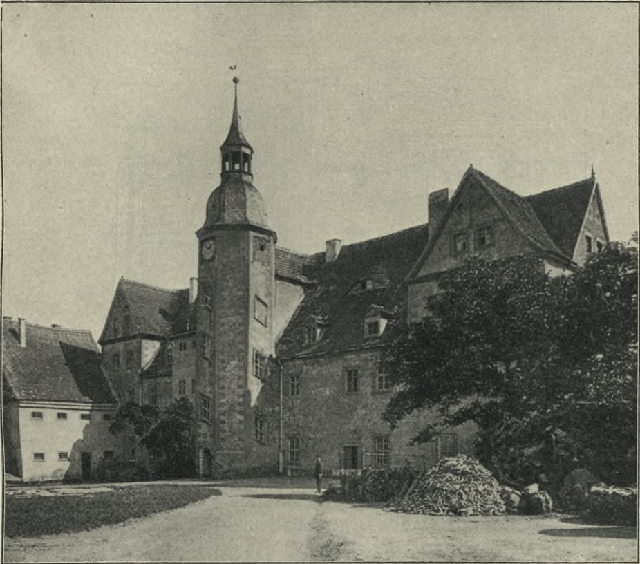
Fig. 460. Nossen, Schloß, Amtshauptmannsgebäude.
