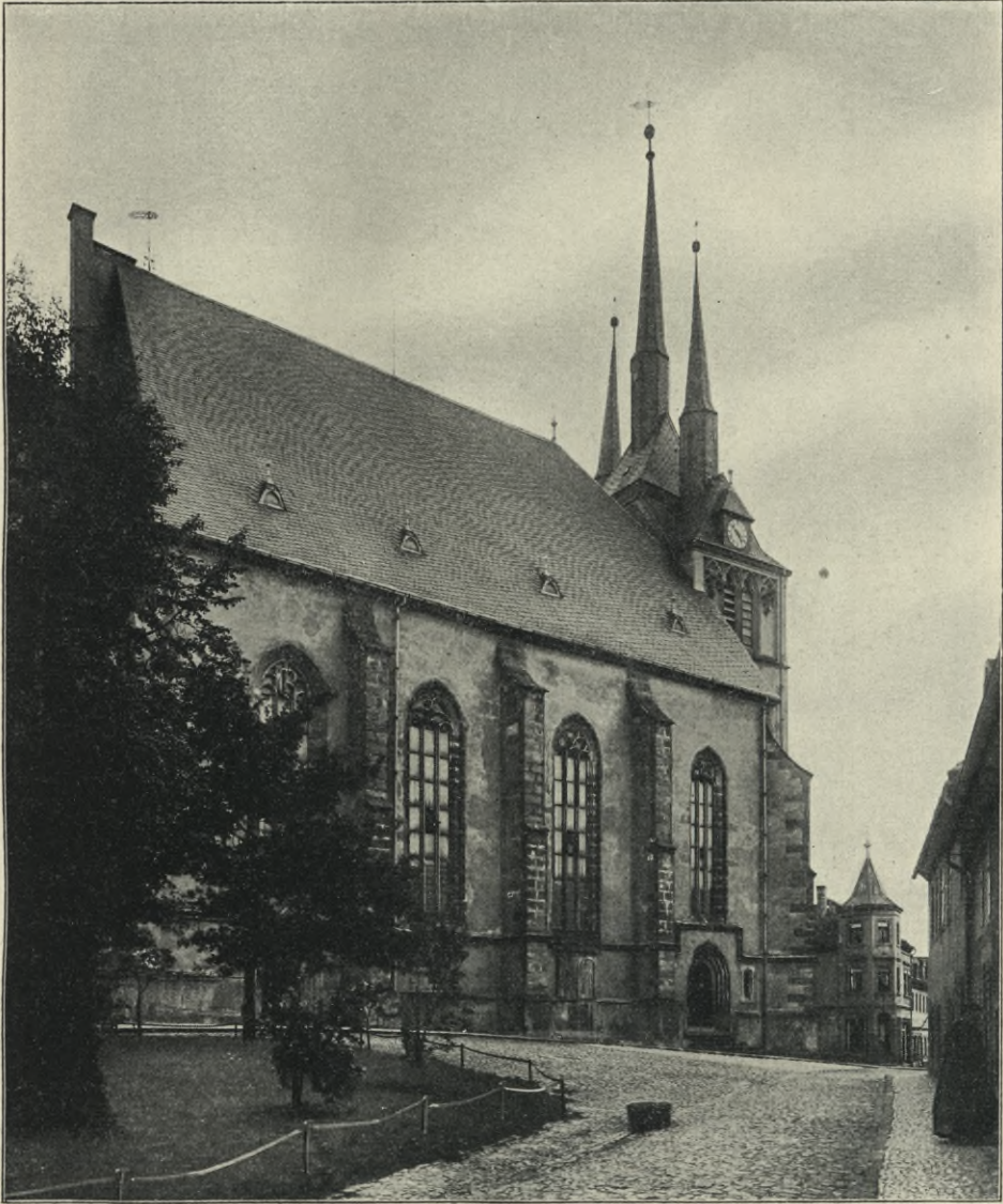
Fig. 364. Lommatzsch, Kirche, Nordseite des Langhauses.
