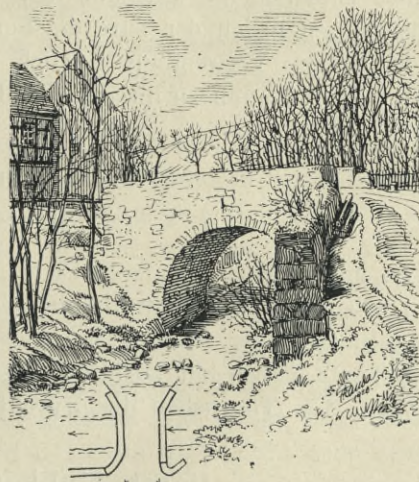
Fig. 282. Klipphausen, Dorf, Brücke.
