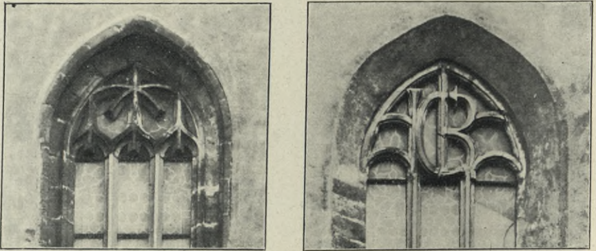
Fig. 367 und 368. Lommatzsch, Kirche, Langhaus, Maßwerk.
