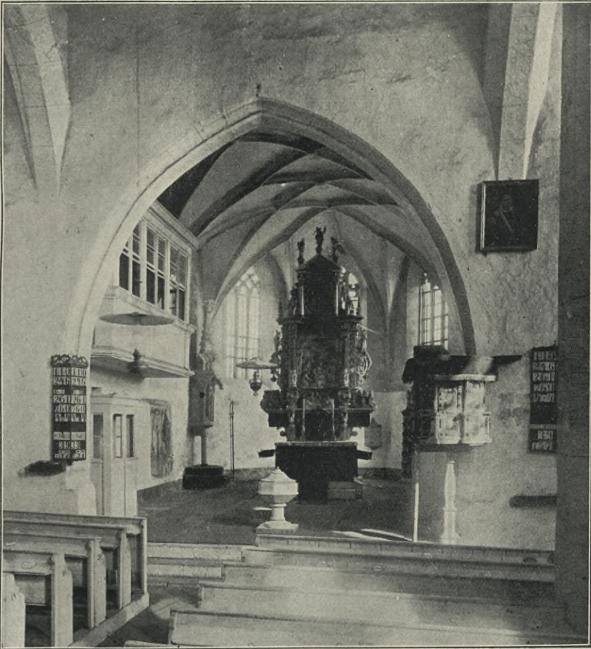
Fig. 136. Burkhardswalde, Kirche, Blick in den Chor.
