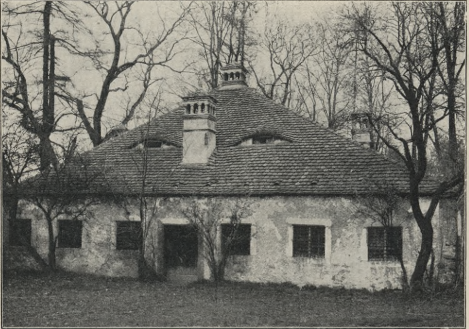
Fig. 587. Zottewitz, Gutshof, Pichschuppen.
