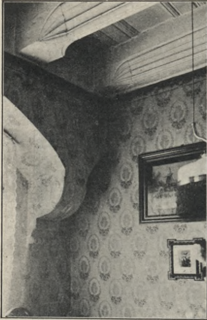
Fig. 416. Seußnitz, Torhaus, Balkendecke.
