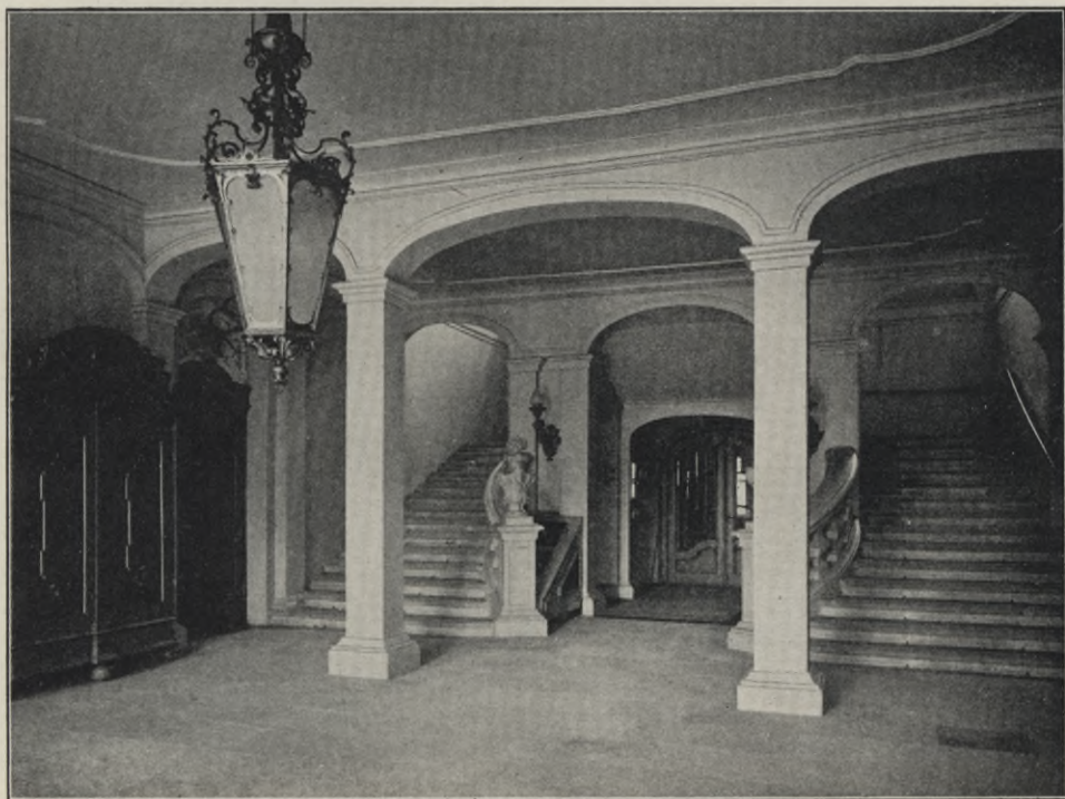
Fig 406. Seußnitz, Schloß, Flur im Erdgeschoß.
