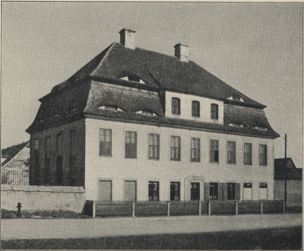
Fig. 286. Ponickau, ehemaliges Herrenhaus.
