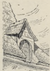
Fig. 317. Rödern, Kirche, Aufzugluke.
