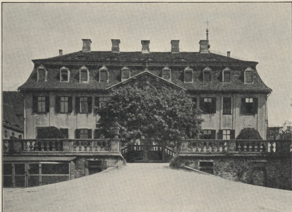
Fig. 404. Seußnitz, Schloß, Hauptbau
