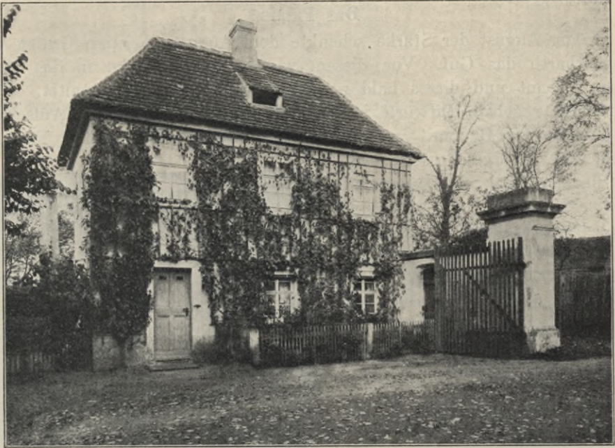
Fig. 559. Zabertitz, Palais, Torhaus.
