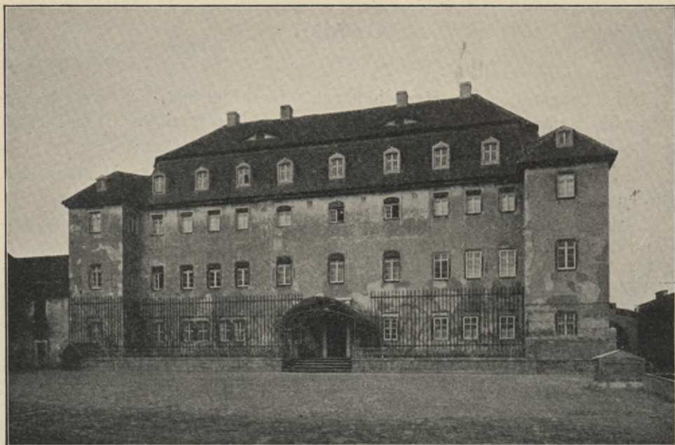
Fig. 604. Grödel, Herrschaftsgebäude, Hofansicht.
