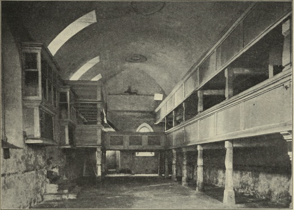
Fig. 77. Marien-Marthenkirche, Inneres des Kirchensaales. Vor dem Abbruch.
