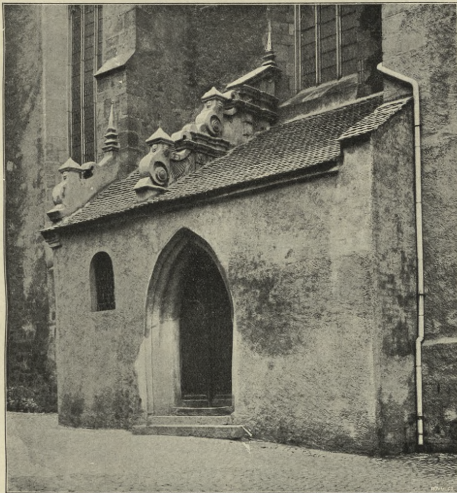
Fig. 25. Dom St. Peter, Nördliche (Gruft-) Vorhalle.
