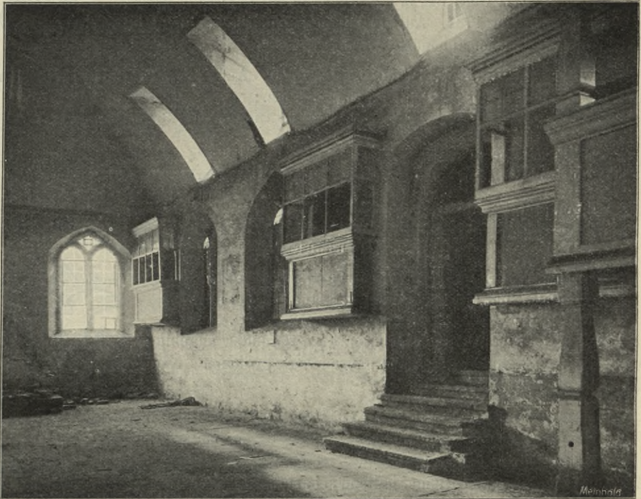
Fig. 76. Marien-Marthenkirche, Inneres des Kirchensaales. Vor dem Abbruch.
