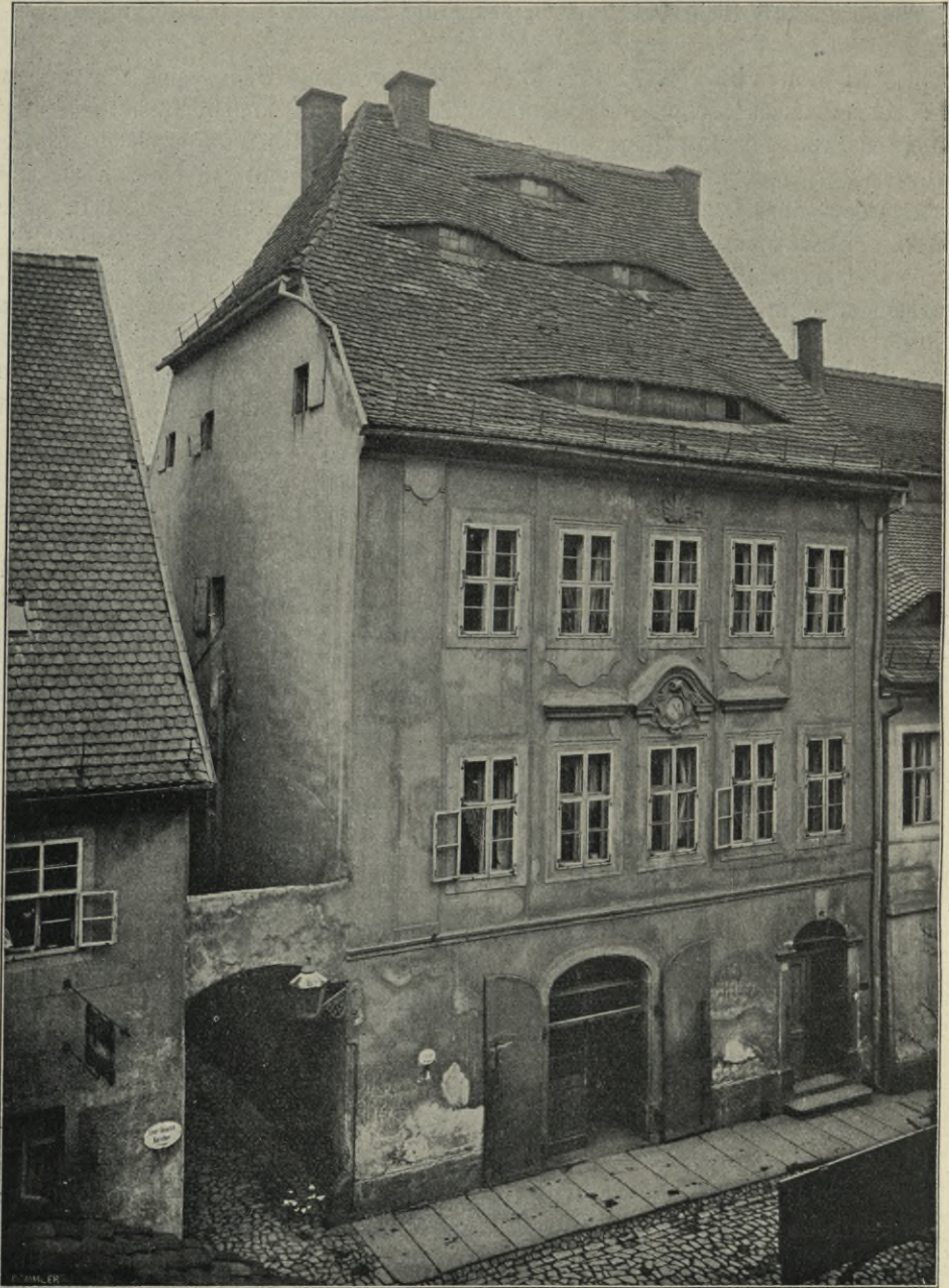
Fig. 335. Kesselgasse Nr. 34, Schauseite.
