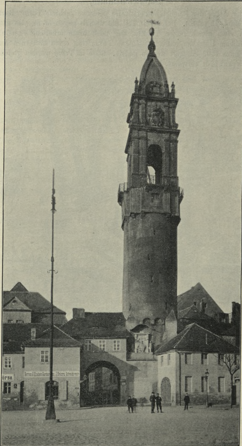
Fig. 226. Reichturm. Ansicht von außen.
