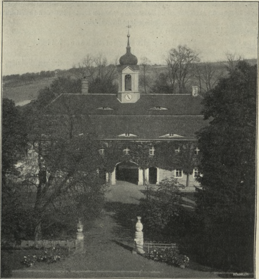
Fig. 230. Rammenau, Schloß, Wirtschaftsgebäude mit Eingang.
