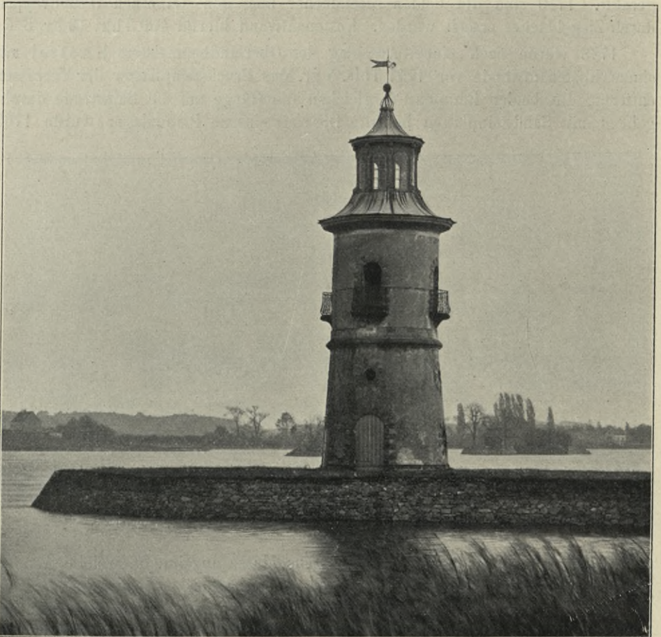
Fig. 115. Moritzburg, Leuchtturm am Grossteich.
