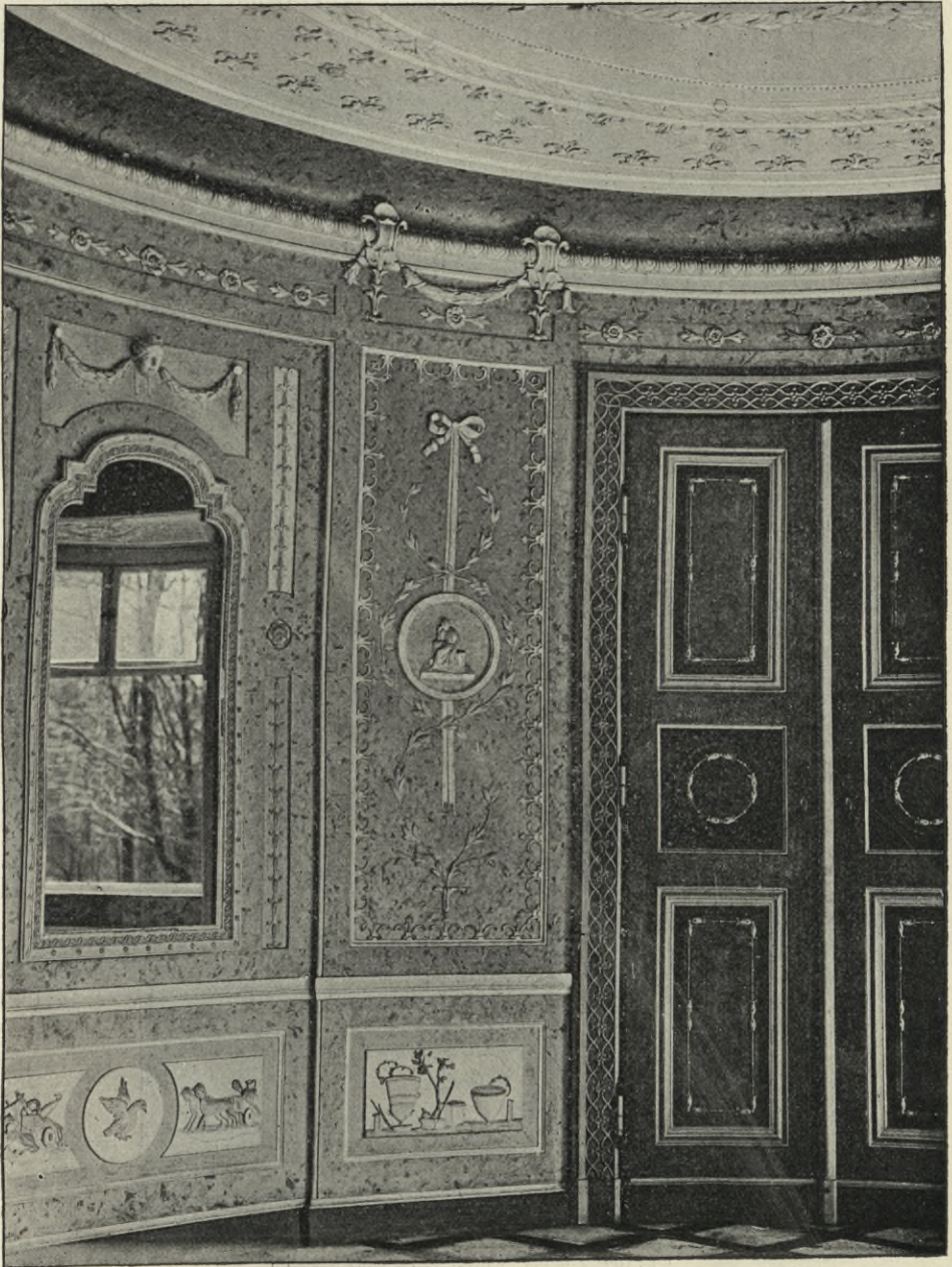
Fig. 178. Pillnitz, Schloss, Englischer Pavillon, Innenraum im Erdgeschoss.
