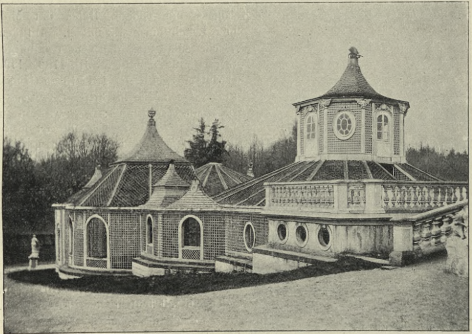
Fig. 116. Moritzburg, Volière am Fasanerieschloss. Zustand vor dem Abbruch.
