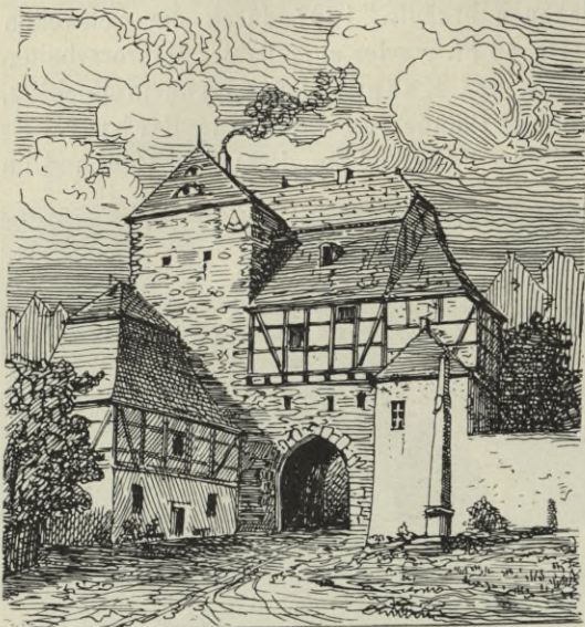
Fig. 166. Leisnig, Oberthor. Zustand vor dem Abbruch.
