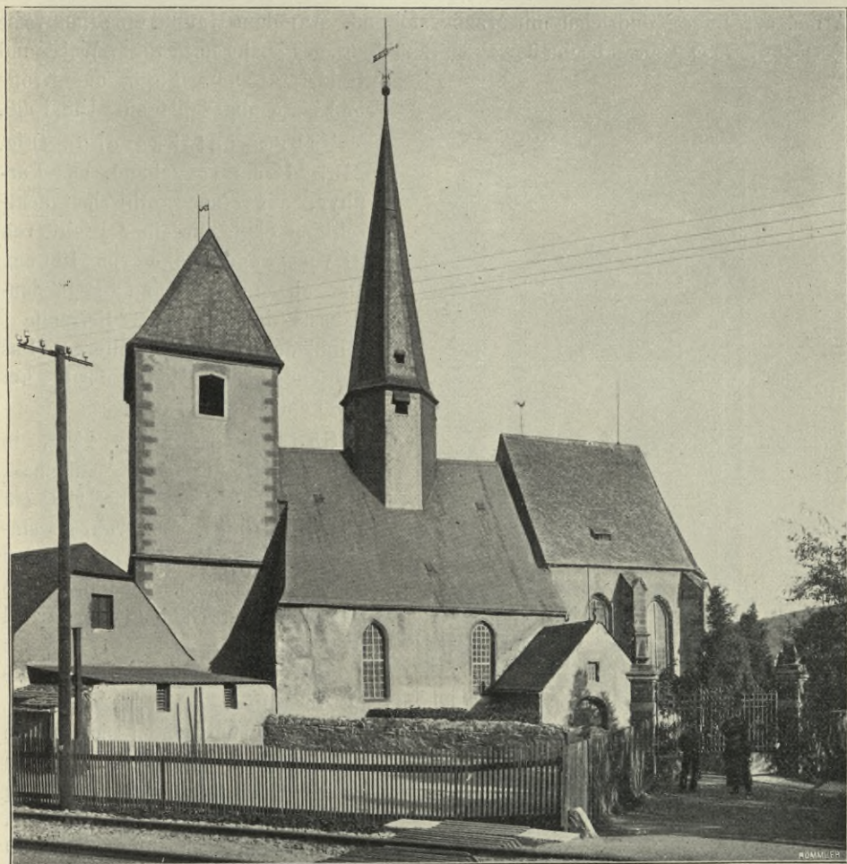
Fig. 242. Tragnitz. Kirche, Ansicht von Süden.
