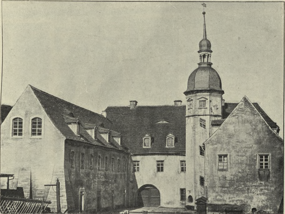
Fig. 80. Nöthnitz, Hof und Treppenthurm.
