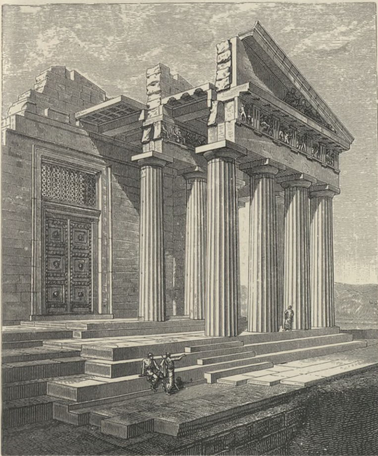
2. Aufbau der Nordostecke des Parthenon in Athen.
