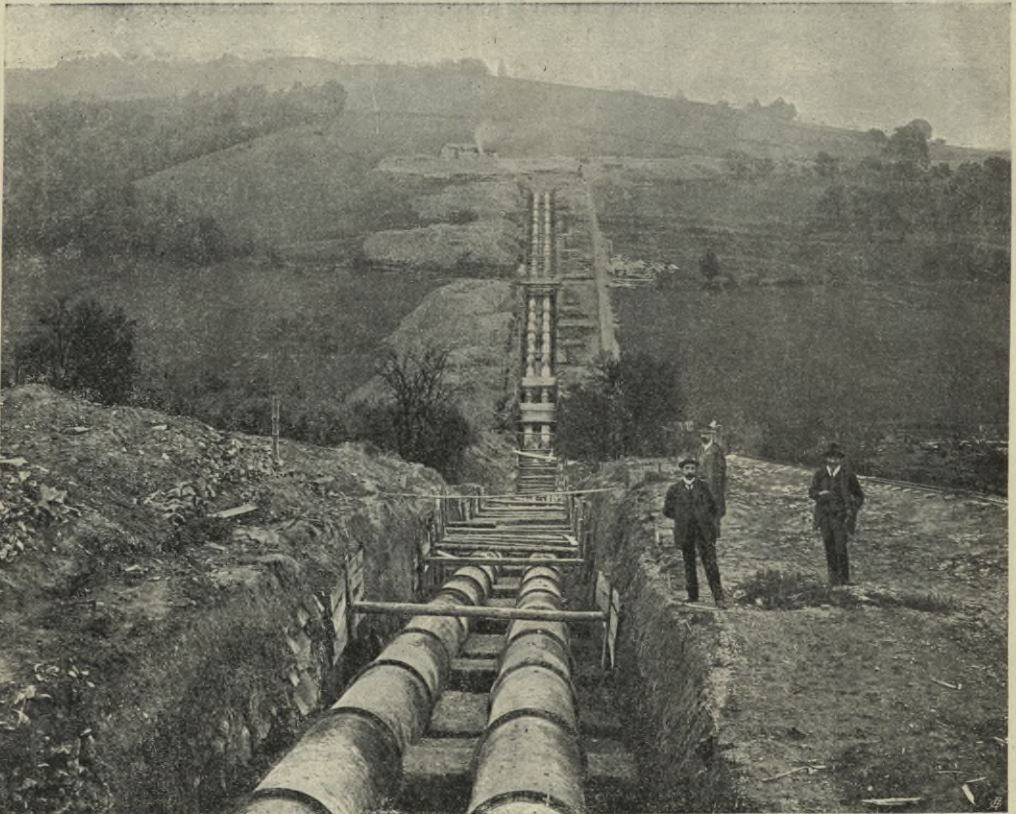
Fig. 10. Bau des Laabenbachsiphons.
