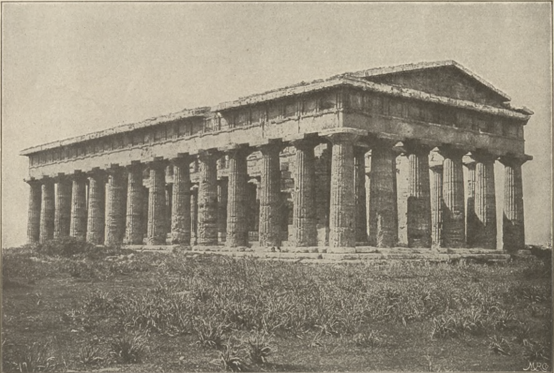
Fig. 51. Poseidontempel von Poseidonia (Paestum) in seinem jetzigen Zustande. Peripteraltempel. Der Kalkstein einst mit Stuck überzogen. Vorn Asphodelospflanzen.
