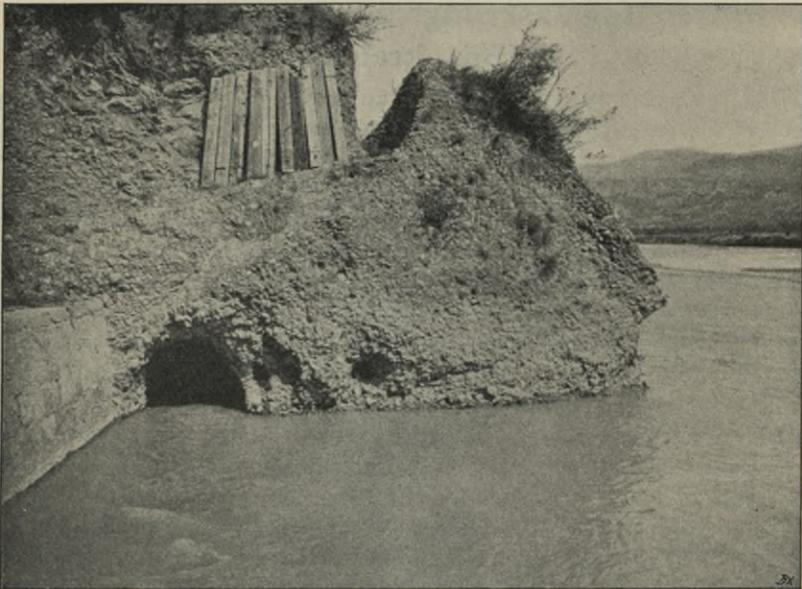
Fig. 477. Durchbrochener Sporn aus Konglomerat, in dessen Schutze sich der Tunneleingang des Kanales befindet.
