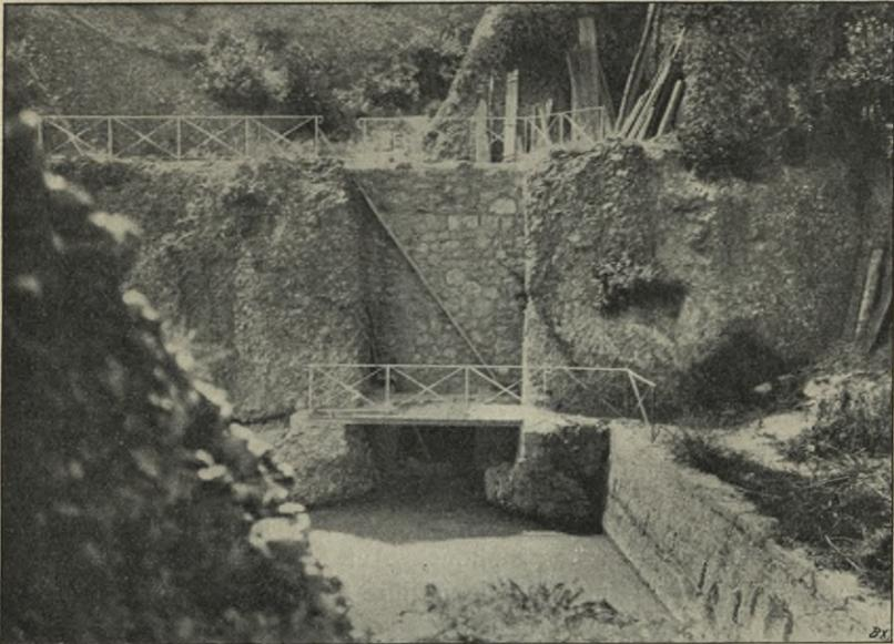
Fig. 478. Einlauf in die Tunnelstrecke des Kanales vor dem Schleusenhaus.
