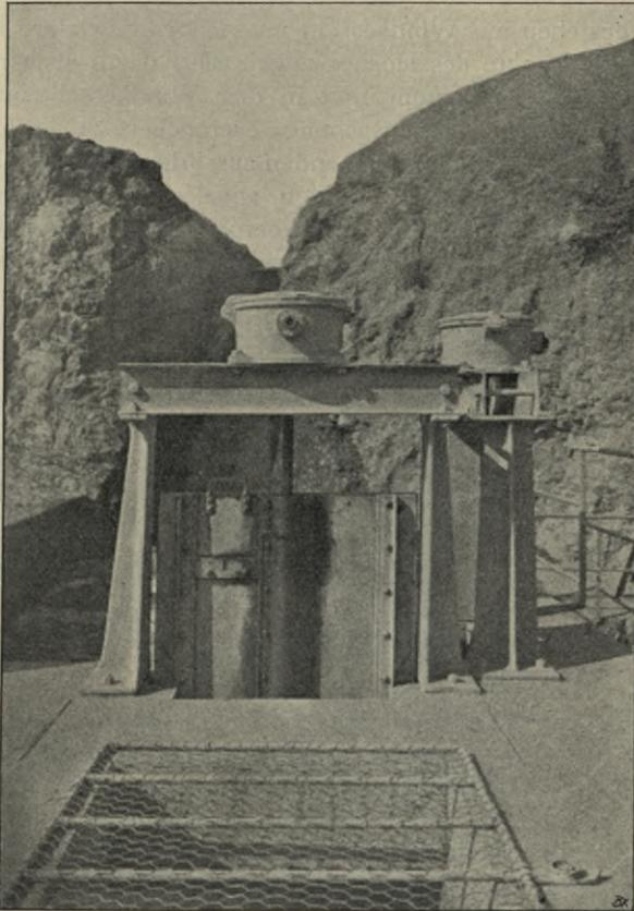
Fig. 481. Schützenaufzug am Siphon von St. Martin am Kanal von Manosque.
