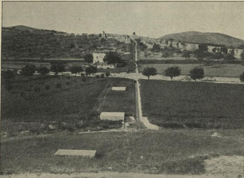
Fig. 483. Siphon von St. Martin. Blick auf den Talhang mit dem Einlaufe, dem Überfallgerinne und den Steinschwellen.
