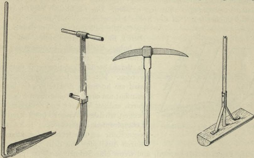
Fig. 293. Schwanenhals. Fig. 294. Stoßpickel. Fig. 295. Spitzhaue. Fig. 296. Sohlenstampfer.
