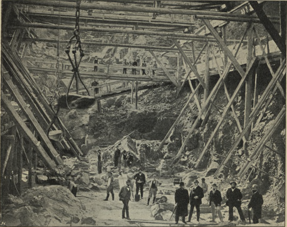
Fig. 168. Beginn der Talsperrenmauerung (Ansicht von unten).
