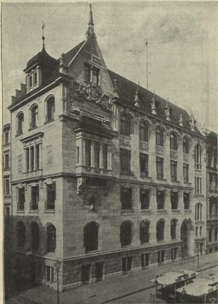
Fig. 145. Das Haus des Vereins deutscher Ingenieure in Berlin. (Arch.: Reimer & Körte.)
