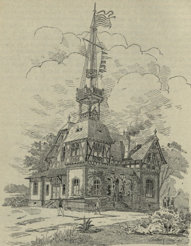
Fig. 83 u. 84. Rudergesellschaft „Germania“ in Frankfurt a. M. (Arch.: Alfred Günther in Frankfurt.) Nach der Architektonischen Rundschau 1886.
