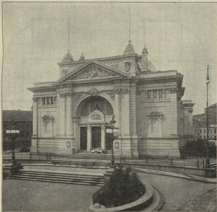
Fig. 65. Stadttheater in Essen a. d. Ruhr. (Arch.: H. Seeling in Berlin) Photogr. Aufnahme von H. Rückward in Gr.-Lichterfelde.
