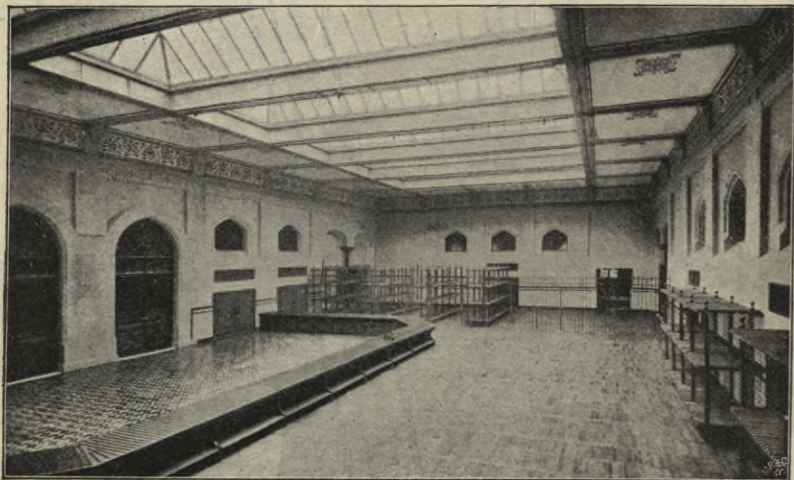
Fig. 62. Das Reichspostgebäude in Strassburg i. Els. — Packetschalterhalle.
