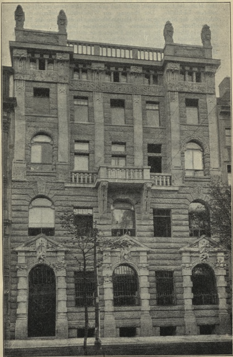
Fig. 60. Die sächsische Handelsbank. Ansicht in der Johannes-Allee. (Arch.: Schilling & Gräbner.)
