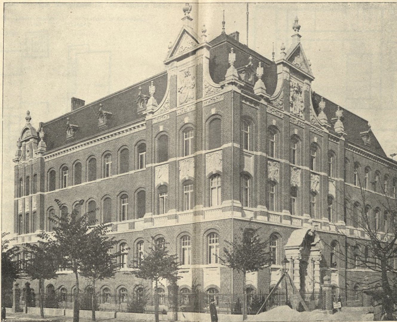
Fig. 121. Das neue Dienstgebäude der Tiefbau-Berufsgenossenschaft zu Wilmersdorf. (Architekten: Becker & Schlüter.) Aus der Zeitschrift „Der Tiefbau“.
