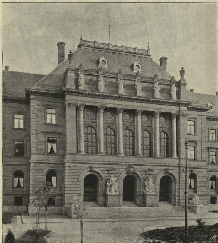
Fig. 81. Land- und Amtsgericht in Ulm a. D. Ansicht des Mittelbaues.
