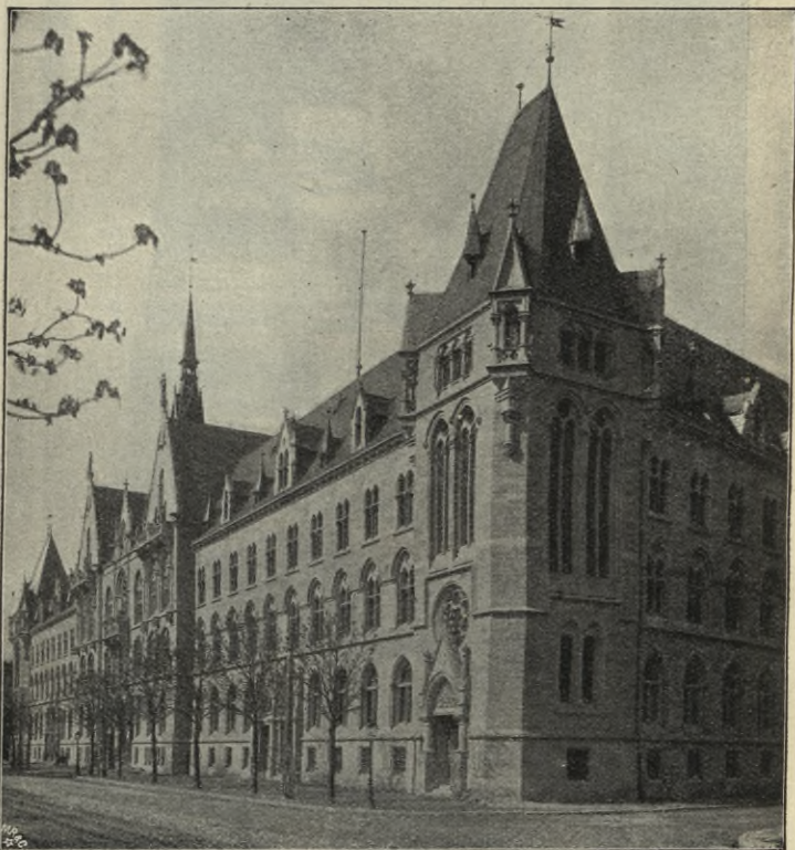
Fig. 58. Oberpostdirektion in Strassburg i. E. — Fassade an der Hohenlohestrasse.
