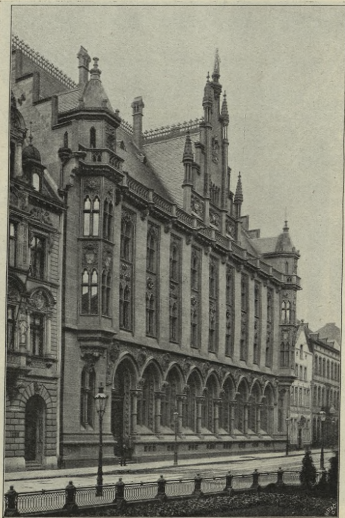
Fig. 15. Die Reichsbank-Filiale in Köln a. Rh. (Arch.: Reg.- u. Brth. M. Hasak in Berlin.) Nach Zeitschrift für Bauwesen 1898.
