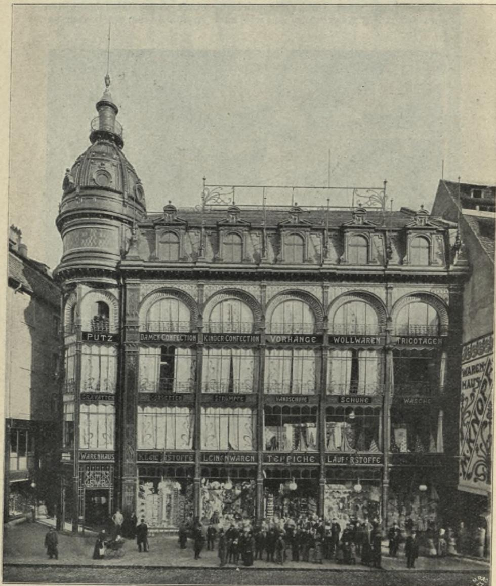
gasse. Da der Grund und Boden sehr theuer war, musste der Raum der verhältnissmässig beschränkten Baustelle auf das Aeusserste ausgenutzt werden. Um das zu erreichen, wurde von einem Steinbau abgesehen, und der ganze Bau wesentlich in Eisen ausgeführt. Auch
