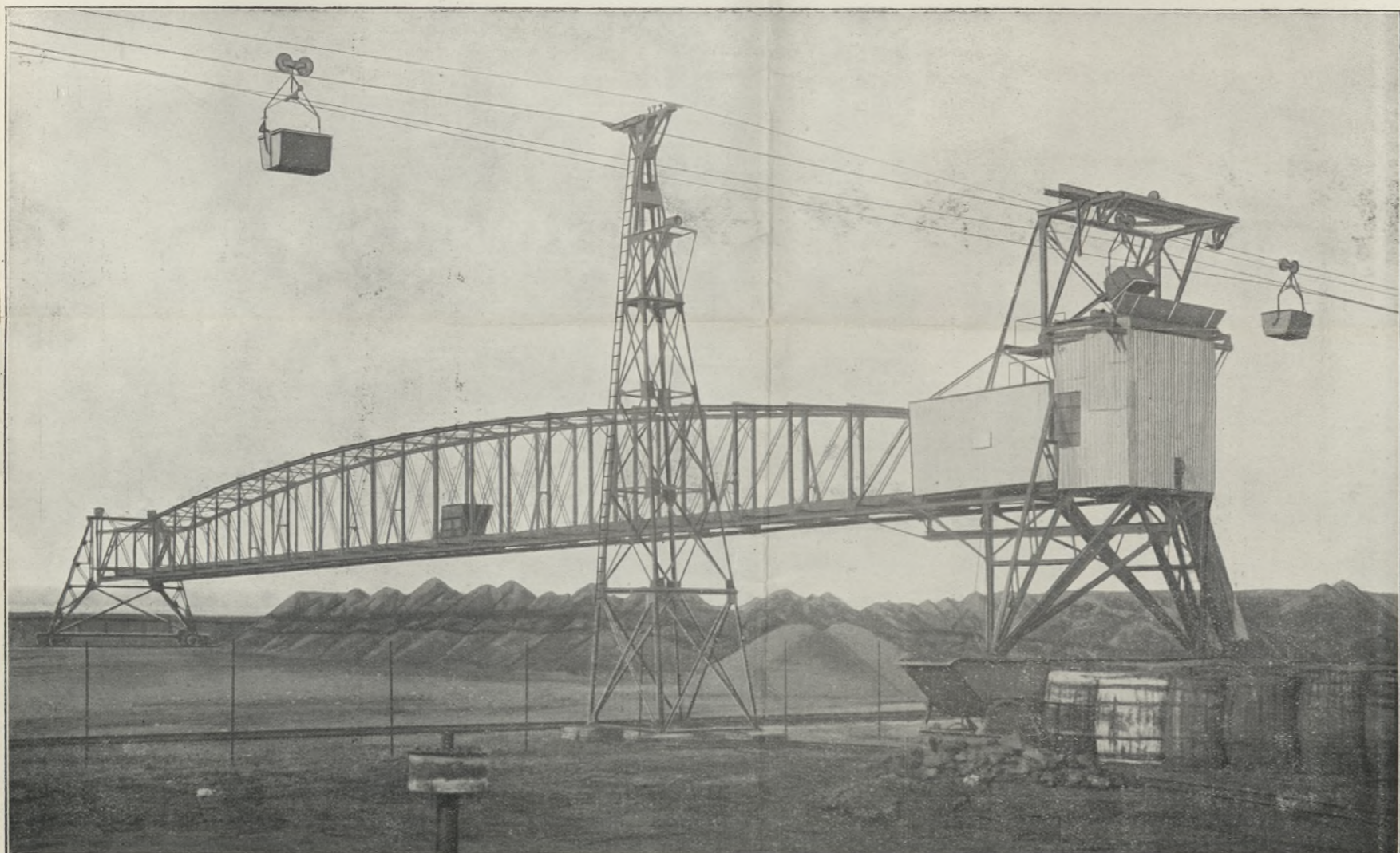
Déchargement automatique des wagonnets du funiculaire sur dépôt par l'intermédiaire d'une trémie et d'une voie automatique, système Hunt. Installation de Griesheim près de Francfort-sur-le-Mein.
