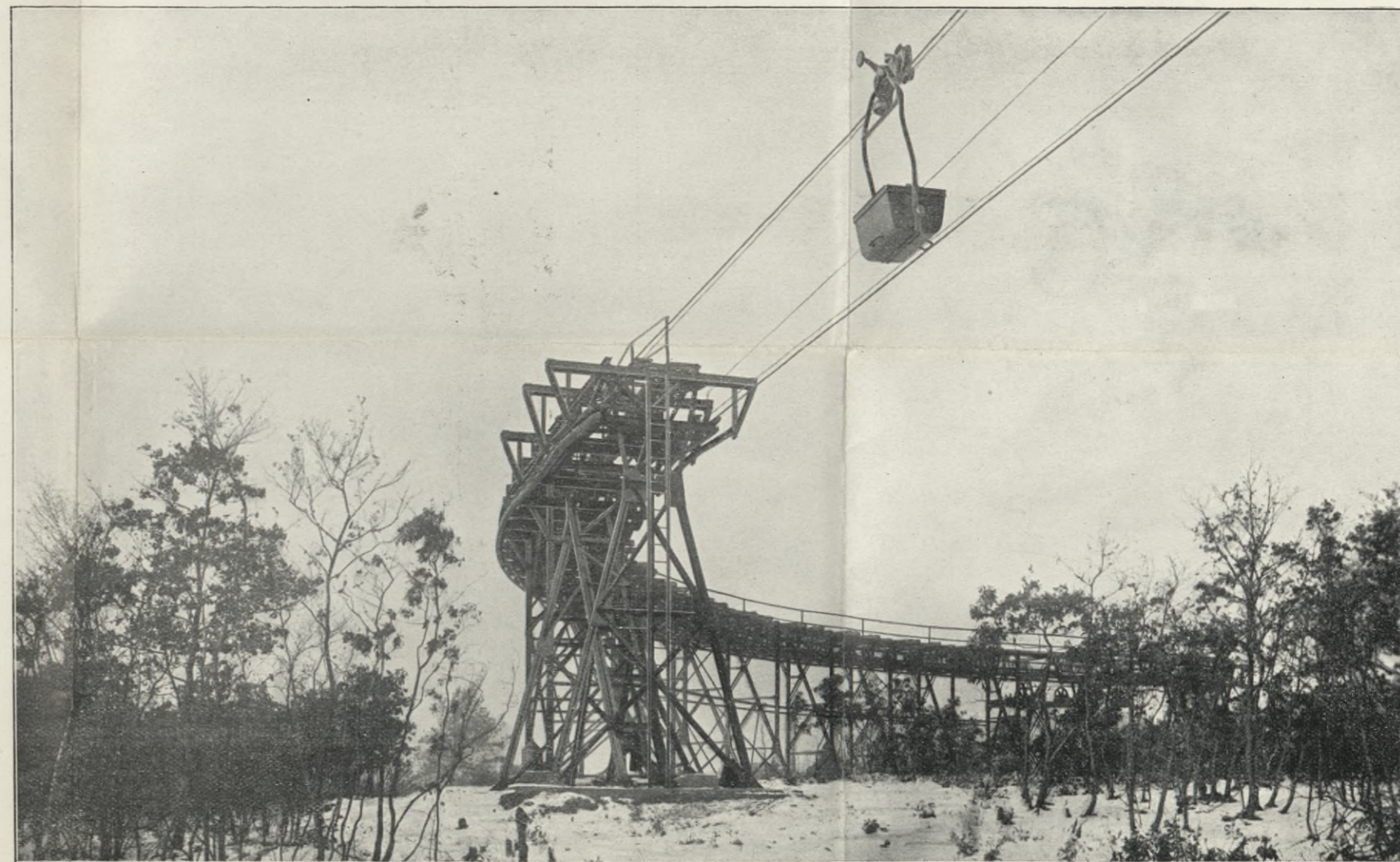
Courbe, funiculaire de Wissen. Les wagons passent la courbe sans se détacher du tracteur.
