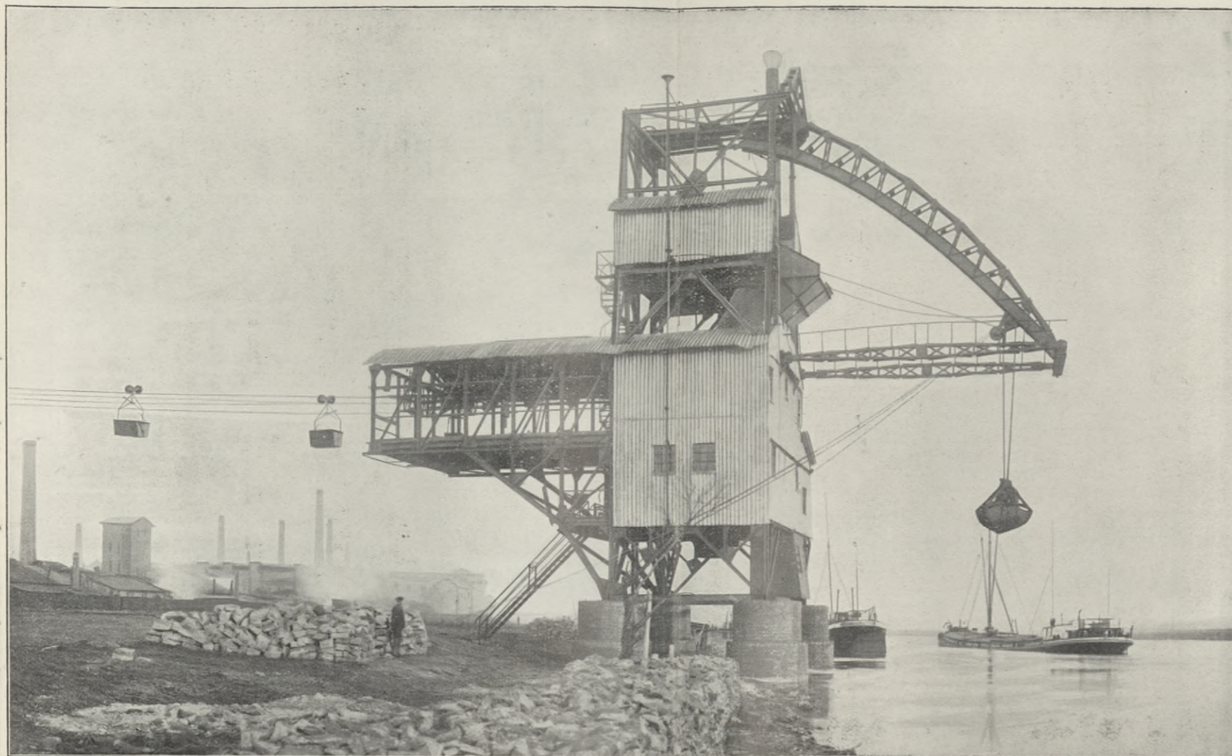
Elévateur, système Hunt, et funiculaire. Installation de Griesheim près de Francfort-sur-le-Mein.
