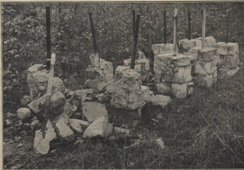
Abb. 3. Verwitterte Mauerwerkskörper aus Kalkstein und Gipsmörtel.
