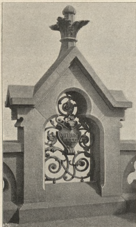
Abb. 187. Geländer-Mittelstück der Cottbuser Brücke.
