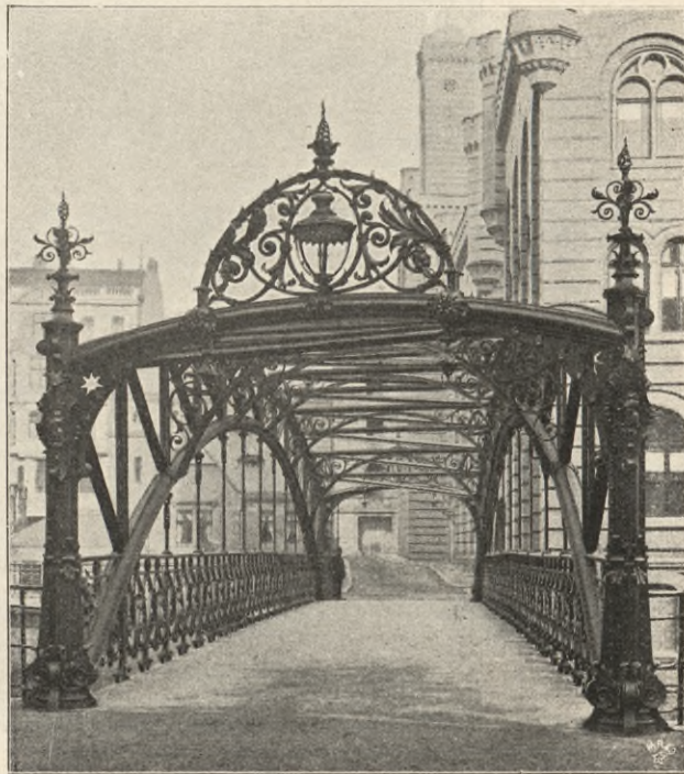
Abb. 135. Portal der Mühlenweg-Brücke über dem Grossen Gerinne.
