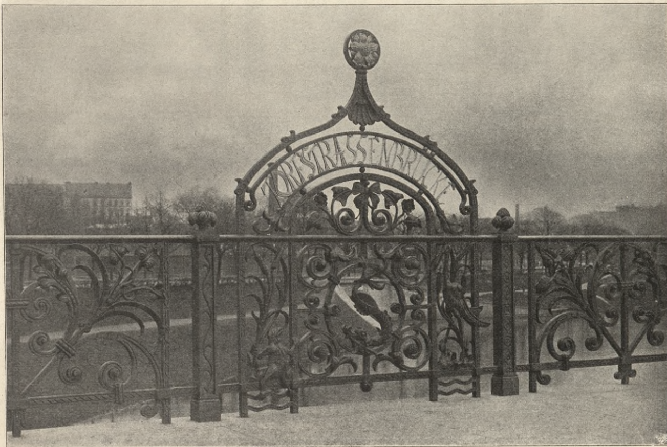
Abb. 101. Geländer der Torfstrassen-Brücke.
