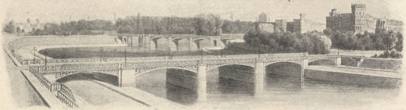
Abb. 41. Die Unterspree-Brücke (im Hintergrunde die Alsen-Brücke).
