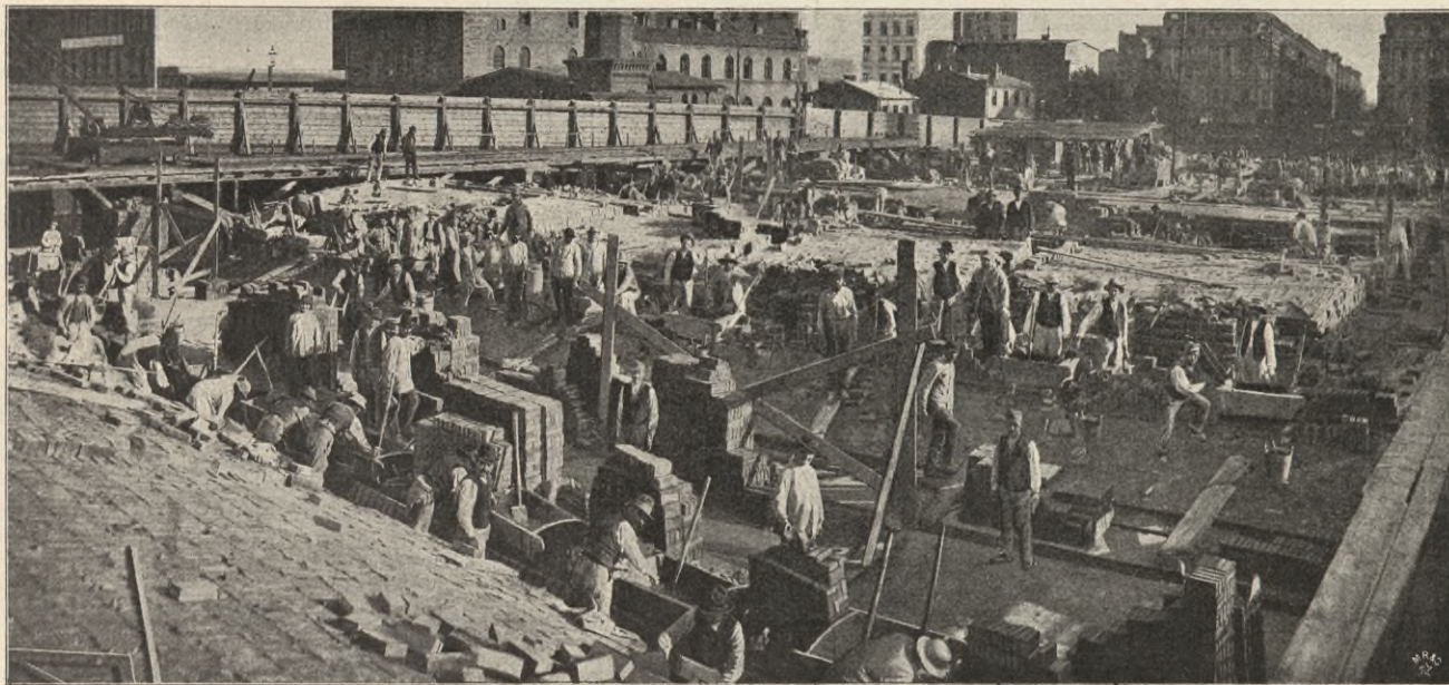
Abb. 126. Die Oberbaum-Brücke im Baue, während des Einwölbens der Flussöffnungen.
