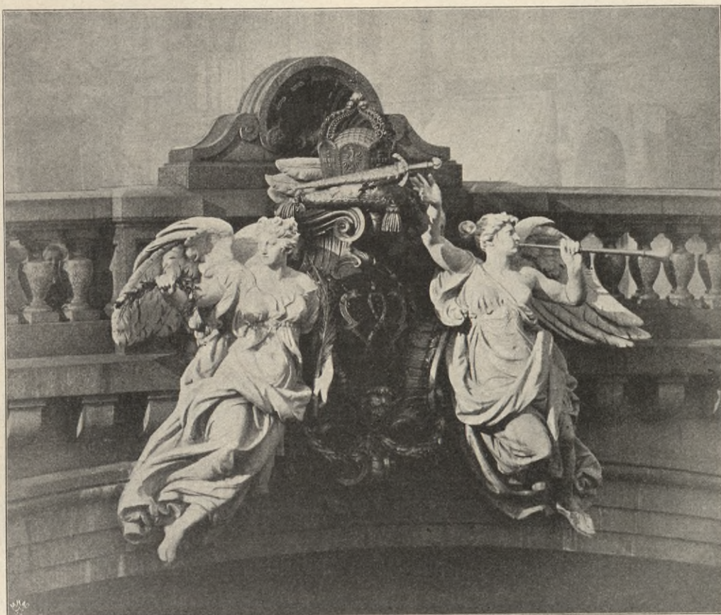
Abb. 106. Schlussstein-Gruppe über der Mittelöffnung der Kaiser Wilhelm-Brücke.
