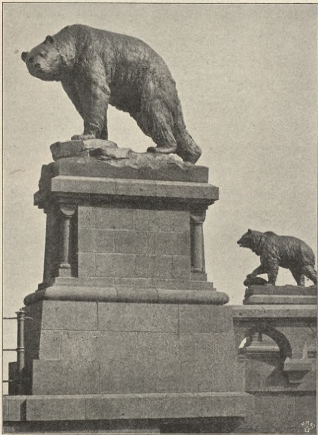
Abb. 110. Bären über den Widerlagern der Moabiter Brücke.
