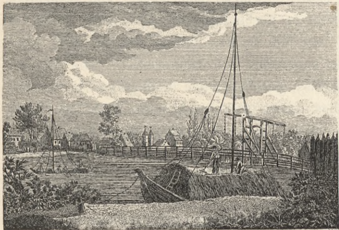
Aufsicht vom Oberbaum nach dem Schleifschiff-Thore.
