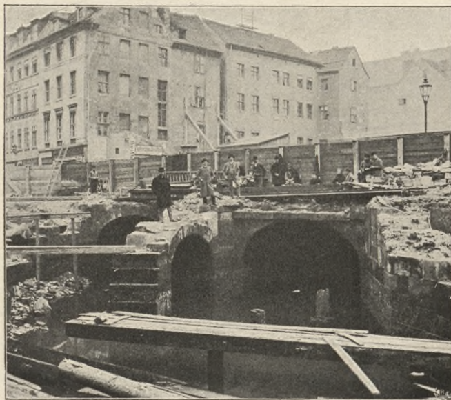
Abb. 137. Die alten steinernen Gerinne des Mühlendamms im Abbruche.
