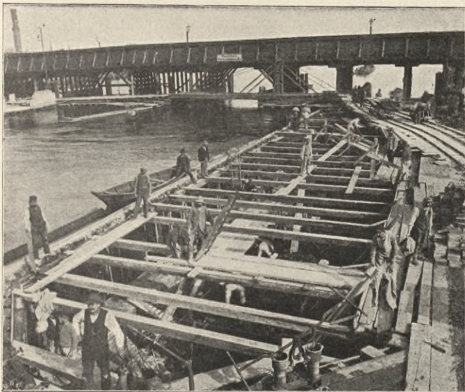
Abb. 123. Gründung des Mittelpfeilers D während des Hochwassers von 1895.
