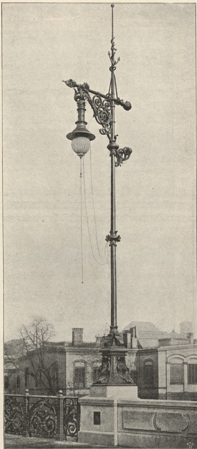
Abb. 95. Ständer für die elektrische Beleuchtung der Eberts-Brücke.
