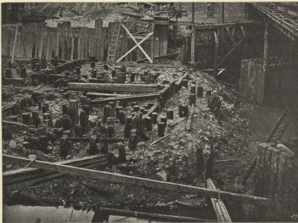
Abb. 136. Altes Gerinne im Abbruche.
