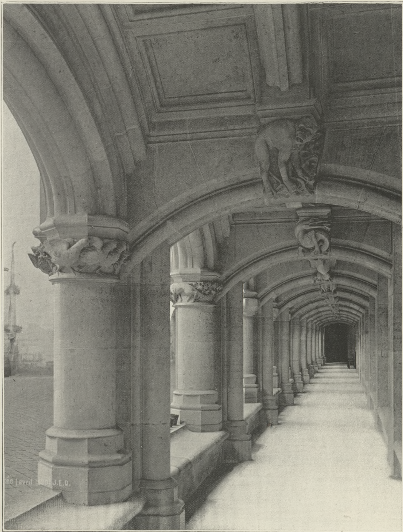
VUE INTÉRIEURE DU PORTIQUE DU REZ-DE-CHAUSSÉE
