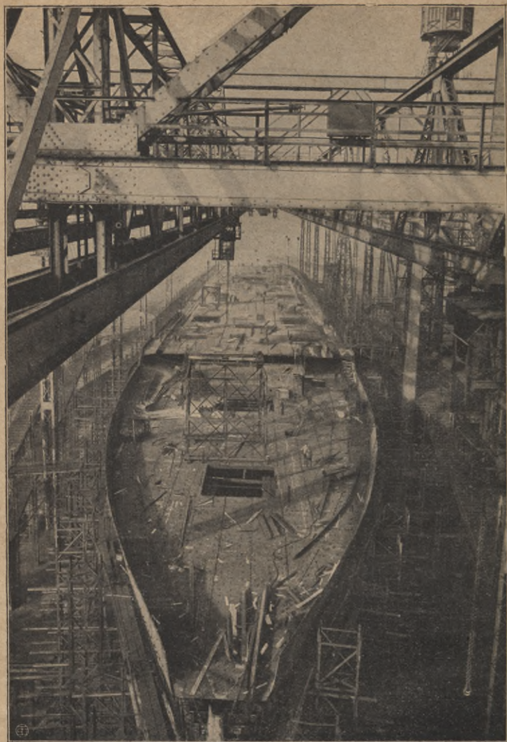
Abb. 25. Der Turbinen-Schnelldampfer „Vaterland“ der „Hapag“ im Bau.
