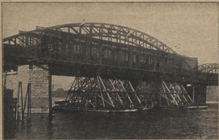
Abb. 5. Das Ausfahren der alten Rheinbrücke bei Köln.
