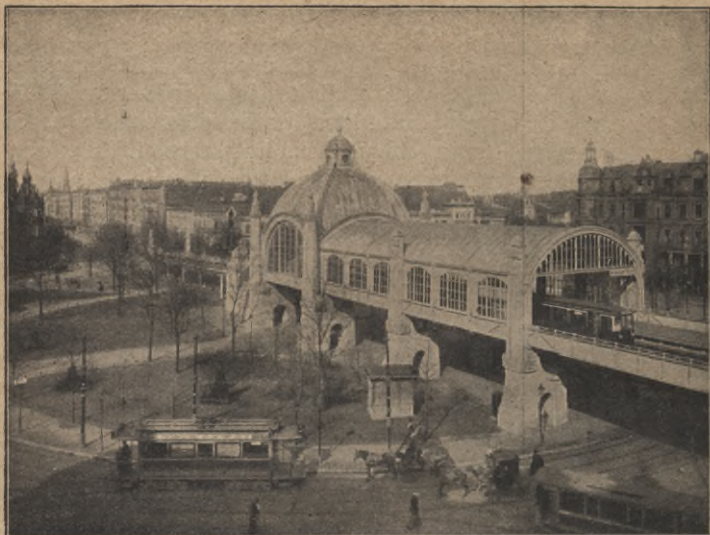
Abb. 19. Bahnhof Nollendorfplatz der Berliner Hochbahn.
