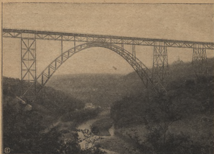
Abb. 1. Die Wupperbrücke bei Müngsten.
