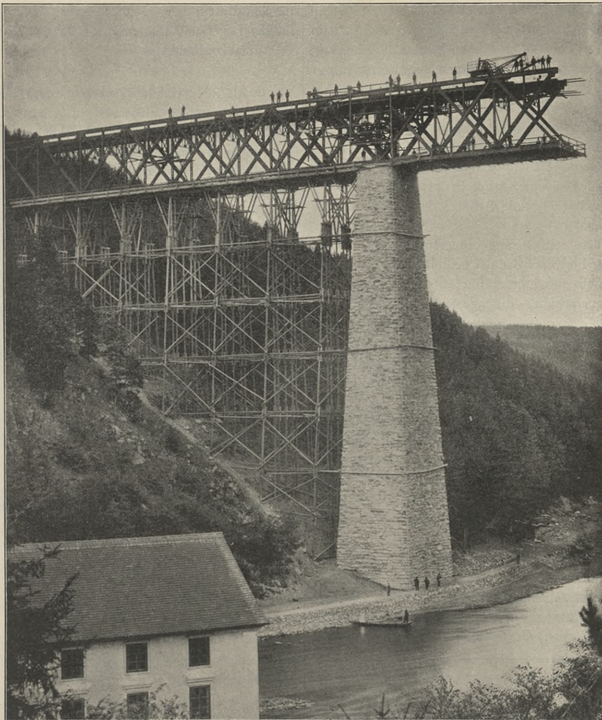
Abb. 108. Die Montage des Cervena-Viaduktes.
