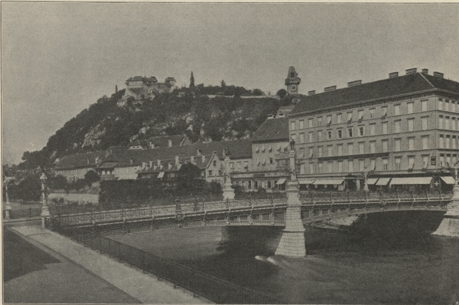
Abb. 101. Die Gesamtansicht der Franz Karl-Brücke über die Mur in Graz.
