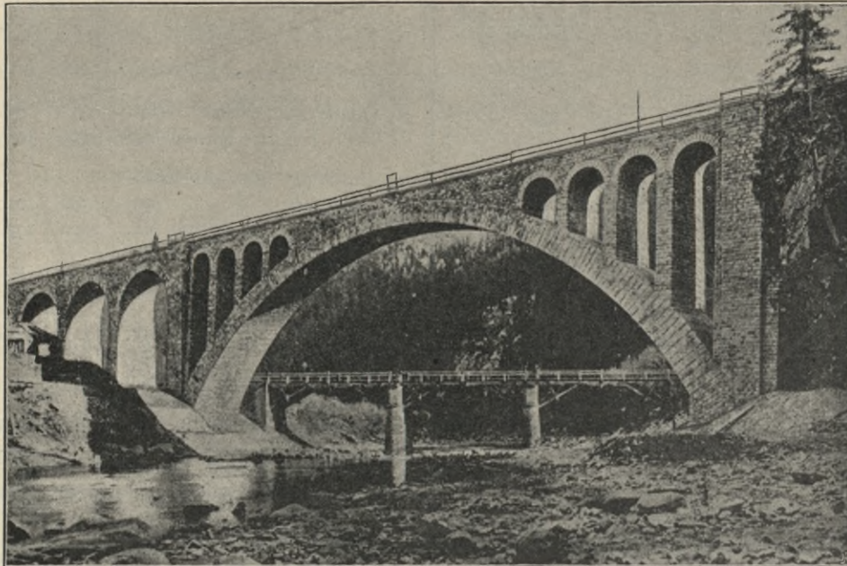
Abb. 160. Gesamt-Ansicht der Jaremcze-Brücke.
