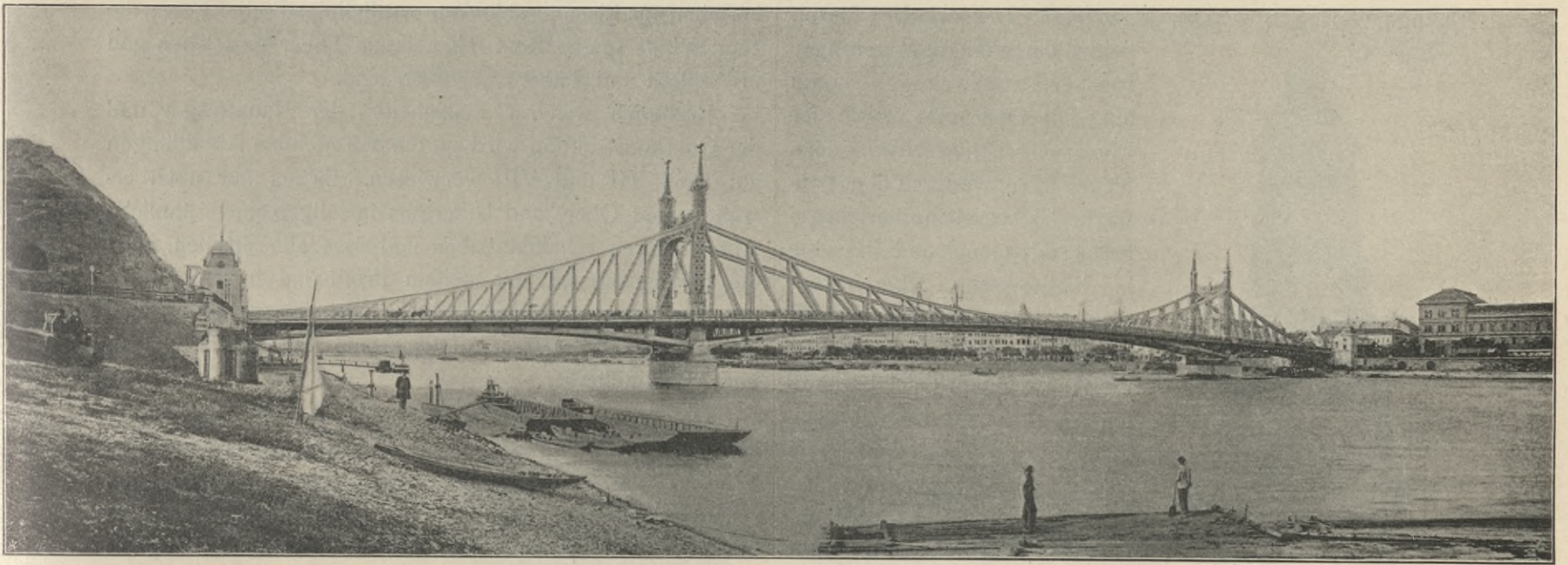
Abb. 110. Gesamtansicht der Franz Joseph-Brücke zu Budapest.
