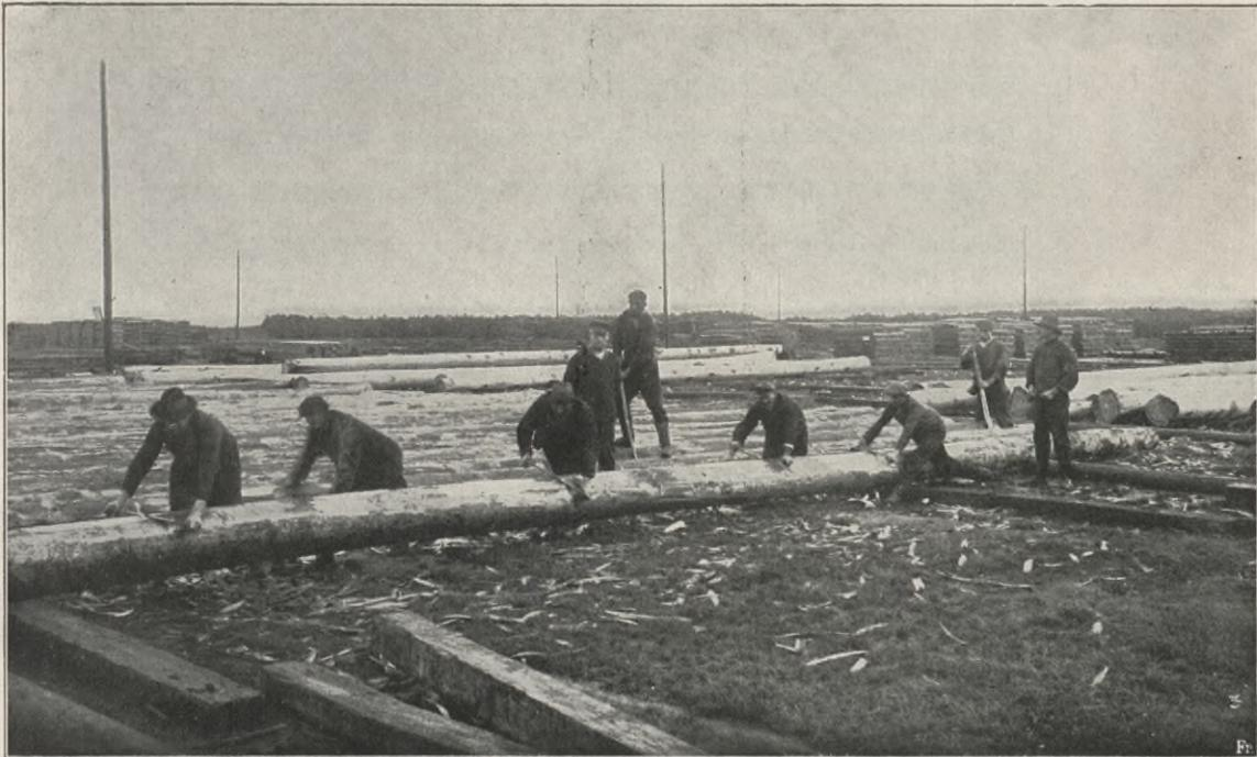
Abb. 20. Das Schälen kieferner Rammpfähle.
