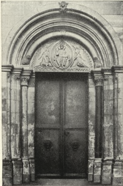
Abb. 4 (Text S. 10) Portal an der Nordseite
