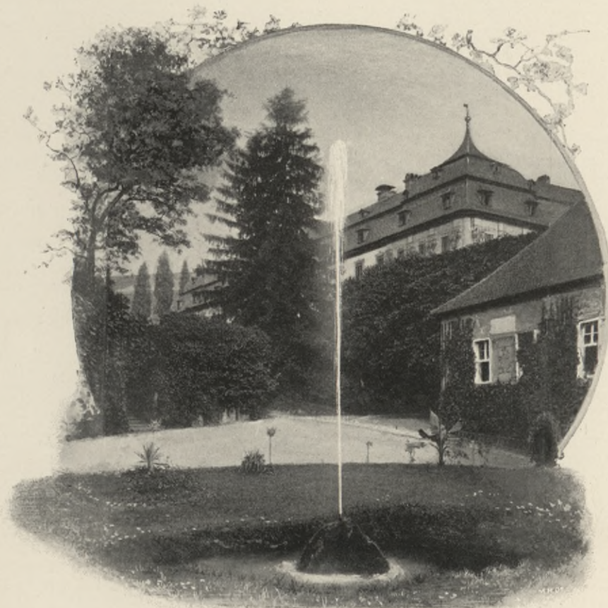
Anlage beim Neubau.
