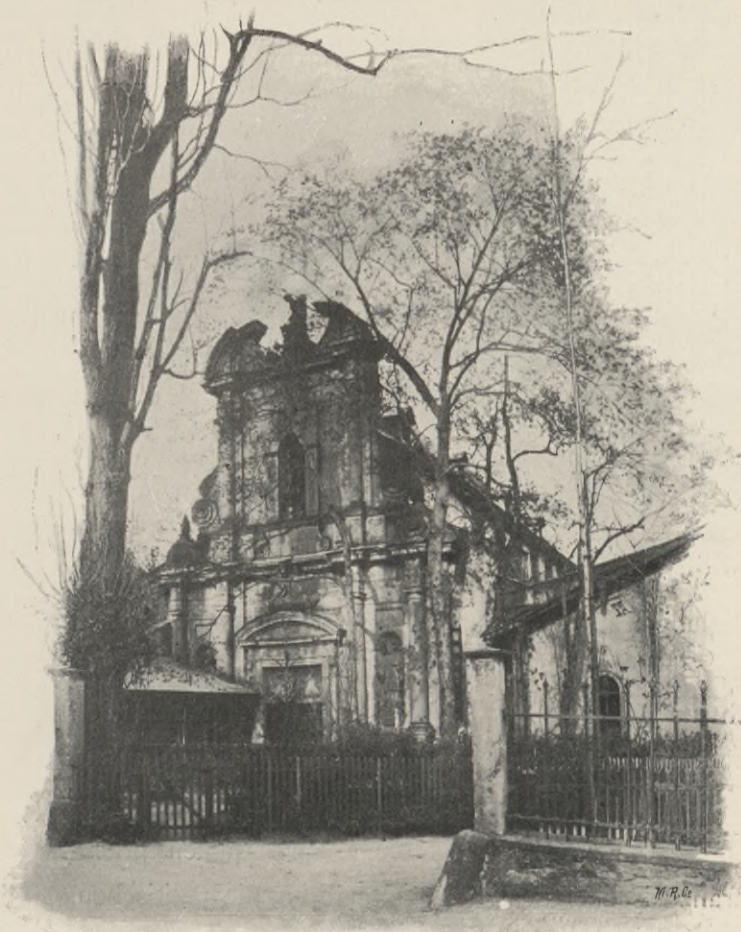
Portal der ehemaligen Klosterkirche.
