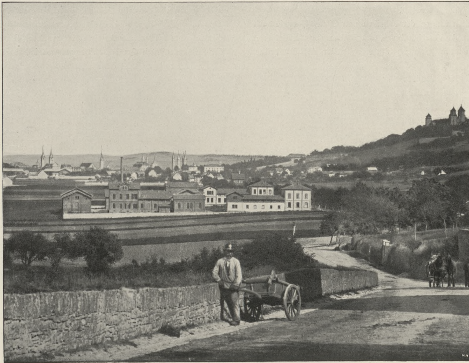
Ansicht der Neuen Fabrik von der Zeller Landstrasse gesehen.
