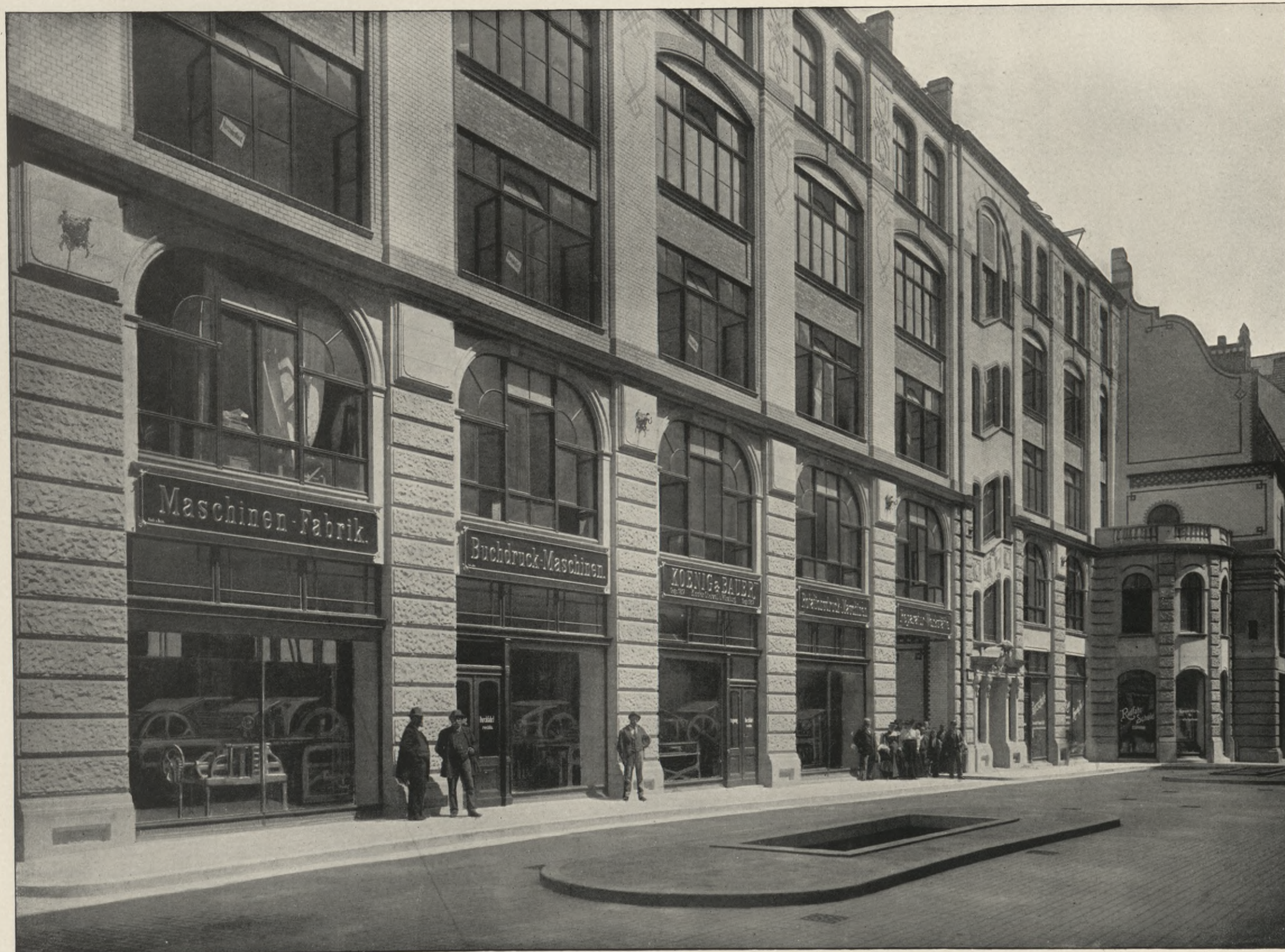
Aeussere Ansicht der Reparaturwerkstätte in Berlin.
