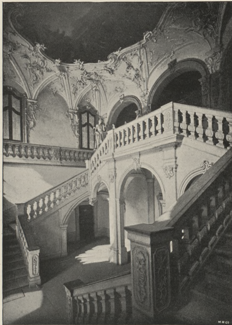
Treppenaufgang der Hauptfçade.
