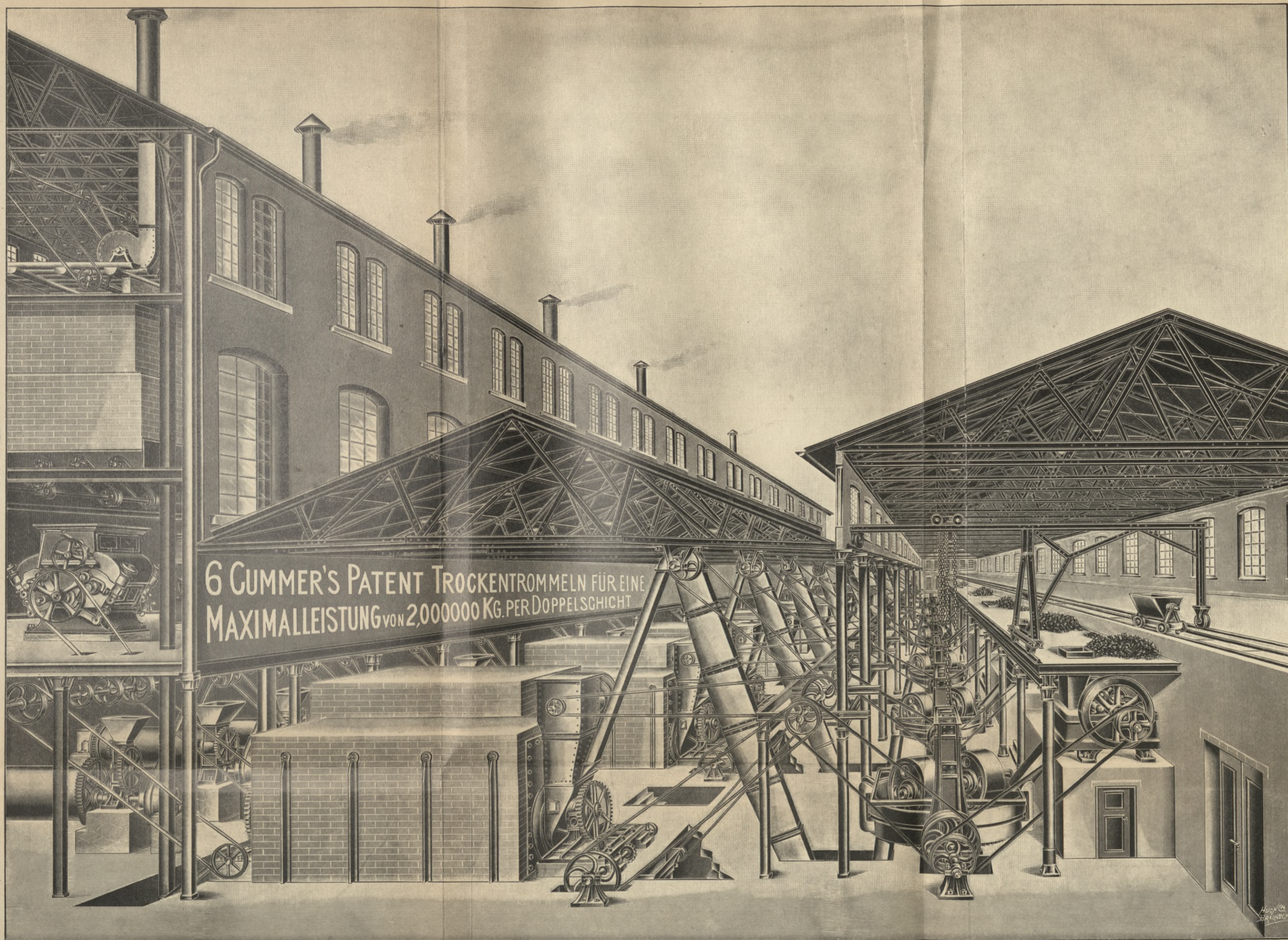
Vorbrecherei und Trocknerei der Hannoverschen Portland-Cement-Fabrik Act. Ges. vorm. (Kuhlemann & Meyerstein), Misburg bei Hannover
