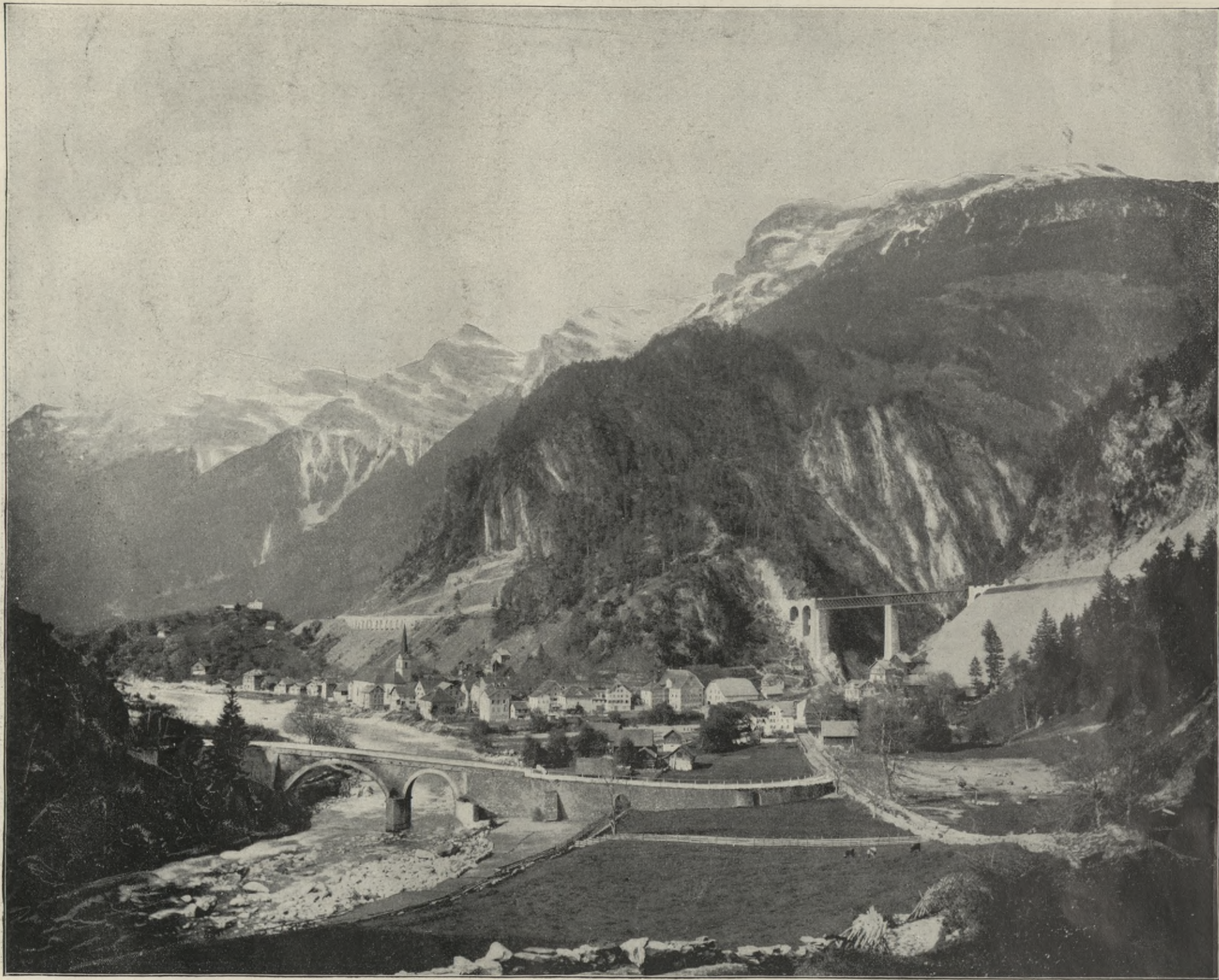
PASS UND BRÜCKE AM ST. GOTTHARD, SCHWEIZ. — Eine wahrhaft königliche Strasse ist's, die über den St. Gotthard aus der Schweiz nach Italien führt. Worte vermögen nicht, die Herrlichkeit dieses Weges wiederzugeben. Bald erklimmt er schroffe Felsen, bald überbrückt er tiefe Abgründe, um sich dann wieder durch liebliche Thäler zu winden. Es ist, als habe der kluge Mensch die mächtigen Alpen besiegt und in Fesseln gelegt! Den Anfang der Strasse bewacht der Löwe von Luzern und bis dort, wo sie tief unten die italienischen Seen erreicht, ist jedes einzelne Glied dieser langen Kette ein herrlicher Punkt, den Handel und Wandel mit goldenem Pinselstrich berührte. Ganz wunderbar ist es, wie hier an gefährlichen Biegungen des Weges ein schützendes Vordach die Wucht der Lavinen oder der Bergwasser bricht. — In unseren Tagen des Dampfes und der Electricität dünkt aber der Weg über die Alpenpässe solchen, die es mit dem Reisen eilig haben, zu lang und so entstand vor wenigen Jahrzehnten das Riesenwerk des St. Gotthard-Tunnels. In einer Ausdehnung von neun und einer halben englischen Meile durchbohrt dieser Wunderbau die Bergkette, und der Tunnel ist weit genug, um zwei Bahnzügen nebeneinander Raum zu gewähren. Welcher Arbeit Tausender von Menschen bedurfte es nicht im tiefen Schoss der Berge, bis sie endlich, durch die haarscharfe Berechnung der Ingenieure, einander die Hände reichten durch die kleine Oeffnung, welche die schweizer und italienische Seite verband.
