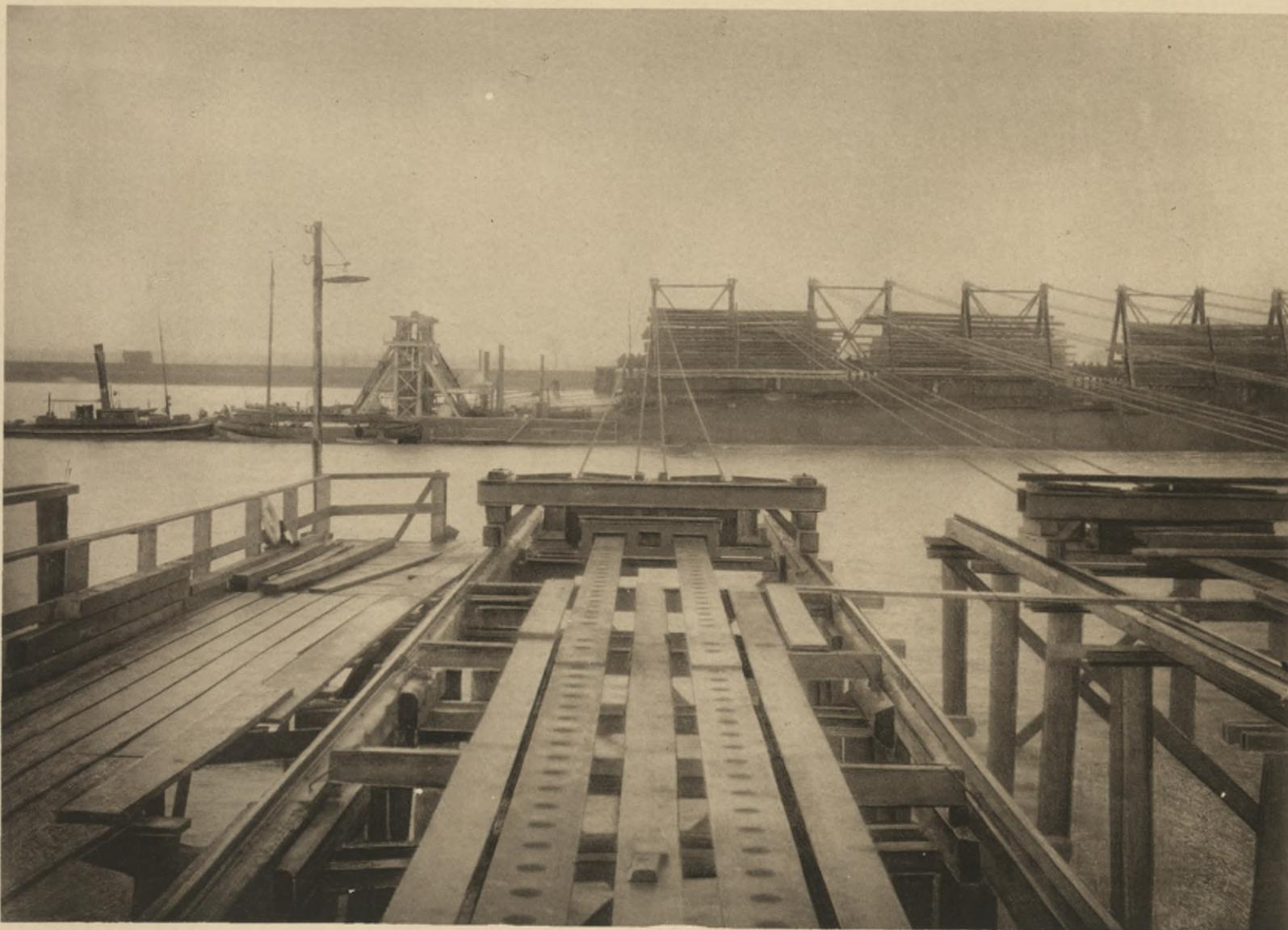
Der vorerwähnte Schlitten trägt auch das Übergangsstück, in dem die sogenannten Leitern angreifen; es sind dies 2 Flacheisen von 370/40 mm, in Abständen von 400 mm, mit Löchern von 140 mm Durchmesser versehen, die zu den hydraulischen Pressen führen. Aus dem Bilde ist die gesamte Anordnung gut ersichtlich. □ □
