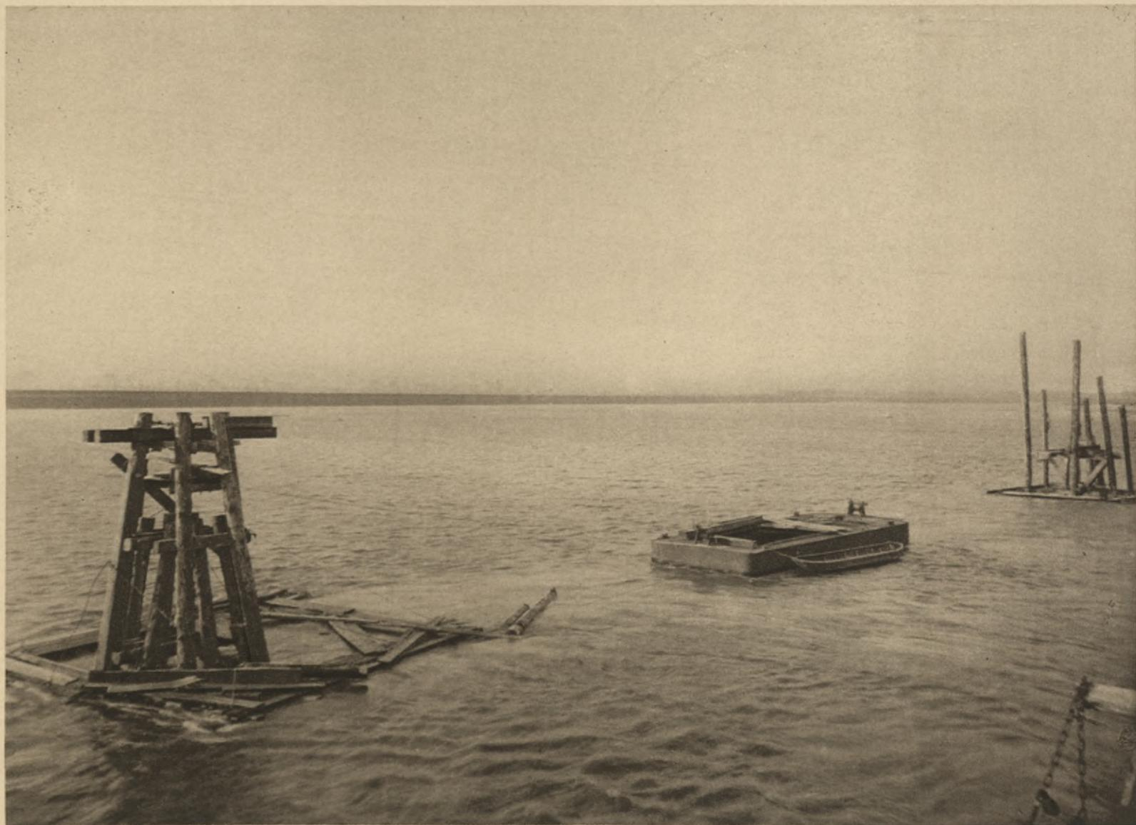
Die 2 Dukdalben zum Zurückverhängen des Schiffes;
