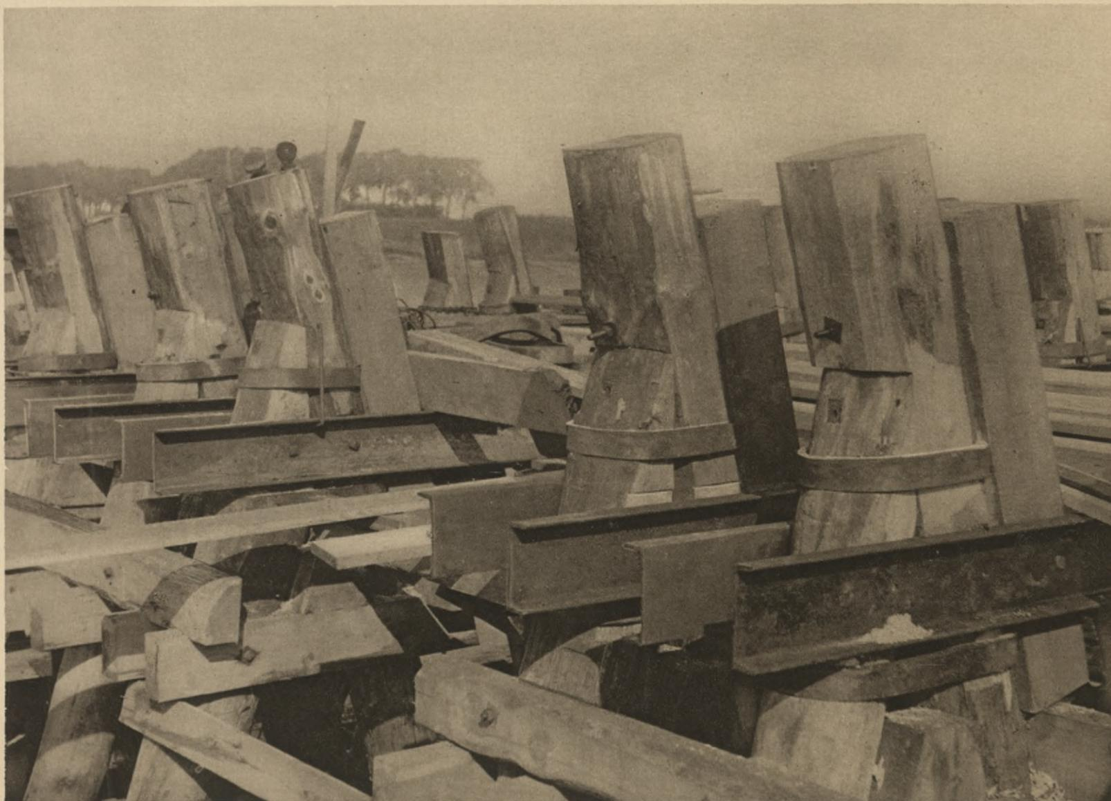
Einzelheiten eines Pfahlkopfes; es waren insgesamt 144 solcher Böcke vorhanden. Die U-Eisenzangen übertrugen die Horizontalkraft durch angenietete Winkel auf Keil- und Beilagehölzer, die ihrerseits mit den Böcken verbunden waren. Bei einer vorausgesehenen Horizontalkraft von 3000 ts mußte jeder Bock 21 ts aufnehmen. Trotzdem zufolge widriger Umstände sogar erheblich größere Kräfte aufgenommen werden mußten, haben sich nur ganz geringfügige Bewegungen von wenigen Millimetern ergeben.
